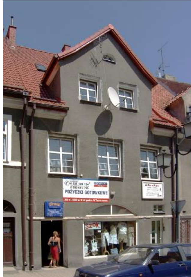
Widok ogólny elewacji
