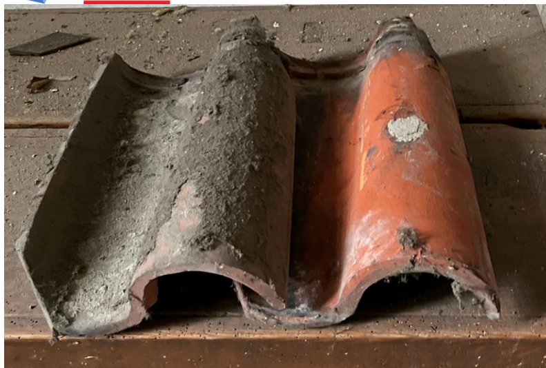
Fot. 2. - Oryginalna dachówka z lat 30. XX wieku – widok od góry.
