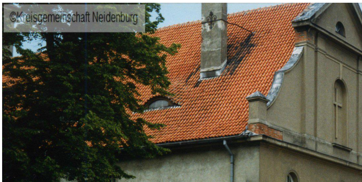
Fot. 5. – Oryginalne pokrycie dachu – stan z pocz. lat 90. XX wieku.
