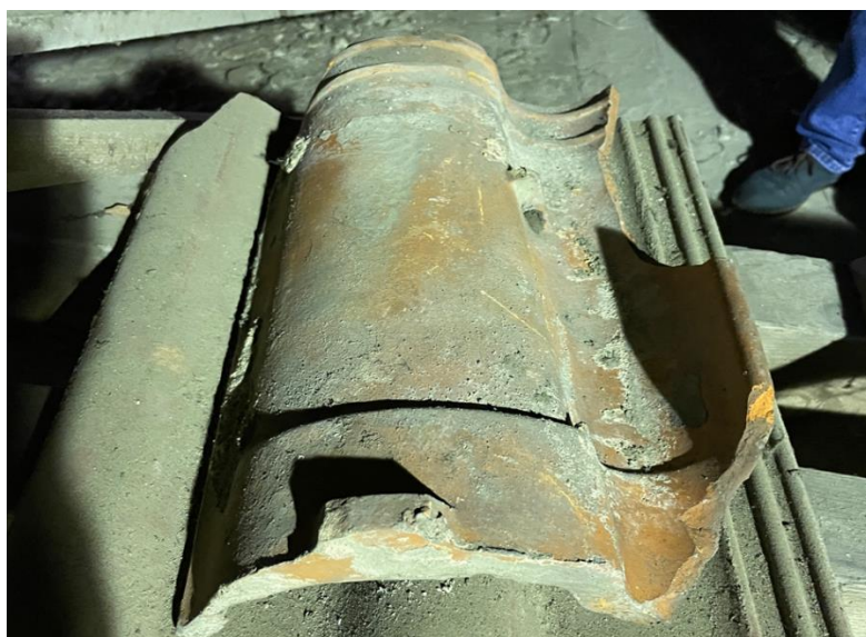
Fot. 3. - Oryginalna dachówka z lat 30. XX wieku – widok od spodu.
