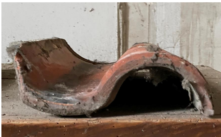
Fot. 1. – Oryginalna dachówka z lat 30. XX wieku – widok od czoła.
