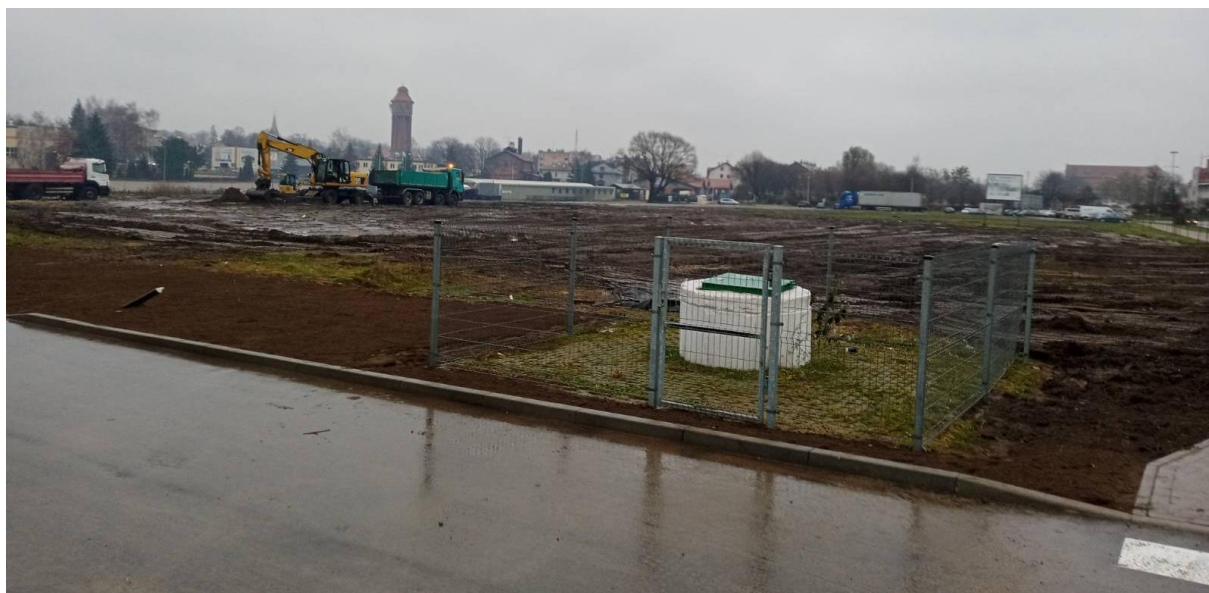
Zdj. 1. Widok na teren nr 1 w kierunku południowo-wschodnim, punkt widokowy na zamek i wieżę ciśnieni (zdj. D. Łąguna).
