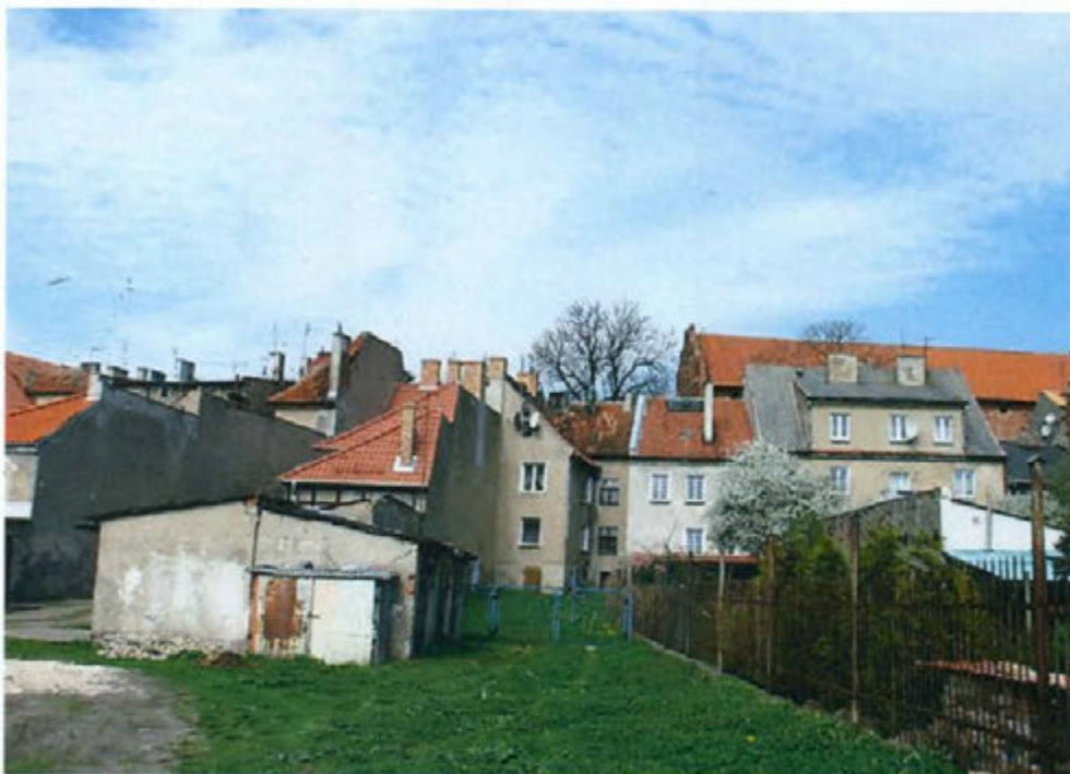
ELEWACJA OD PODWÓRKA
