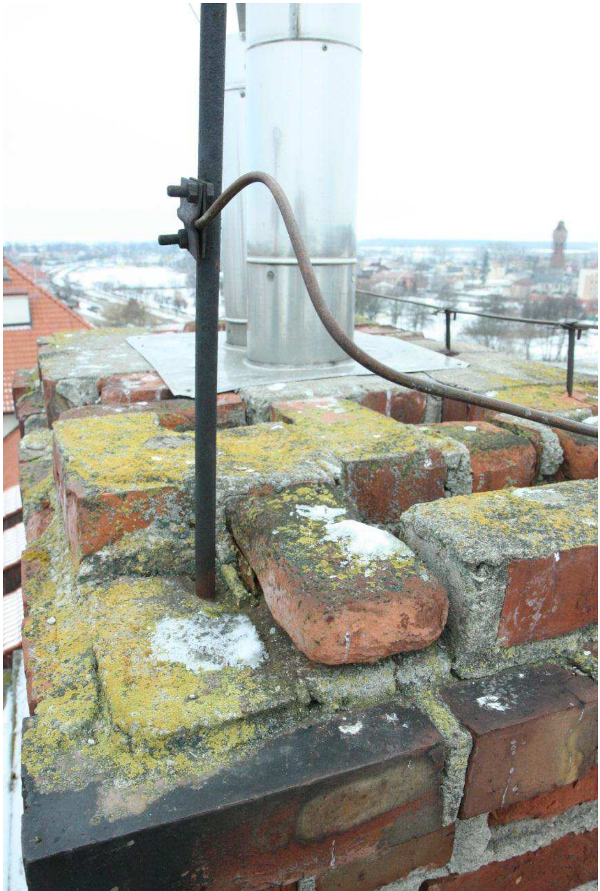
Fot. 5 Górna powierzchnia komina.
