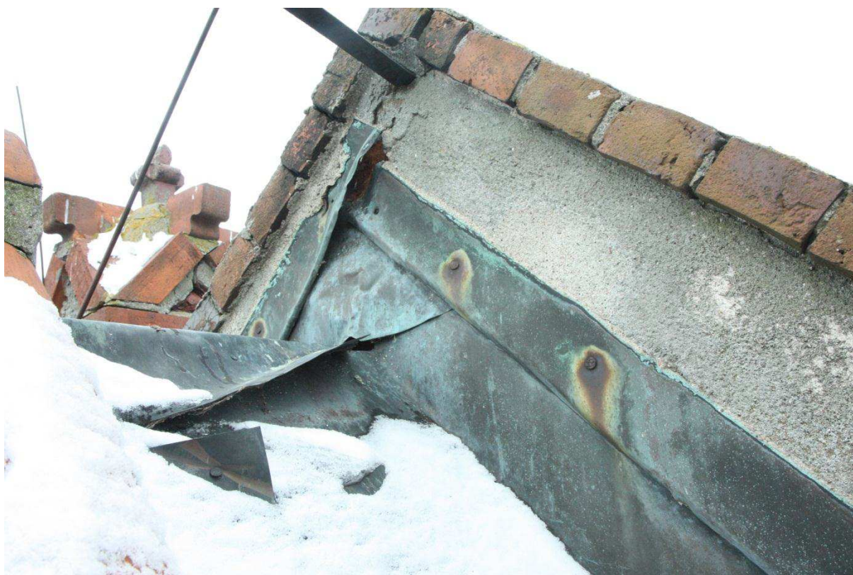
Fot.2 Obróbki blacharskie przymocowane od wewnętrznej strony południowego muru szczytowego.
