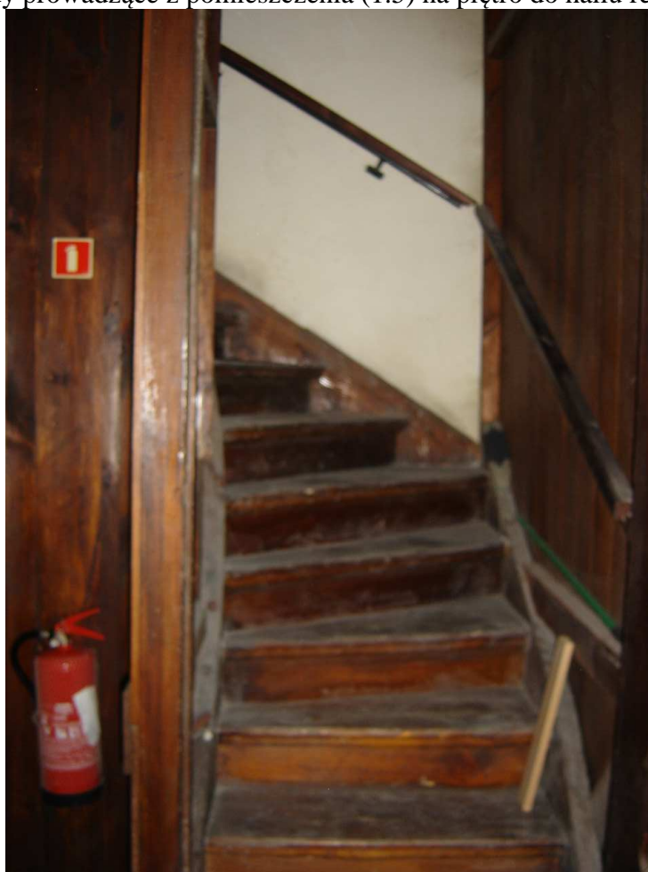
Widok na strome schody prowadzące z hallu reprezentacyjnego na poddasze
