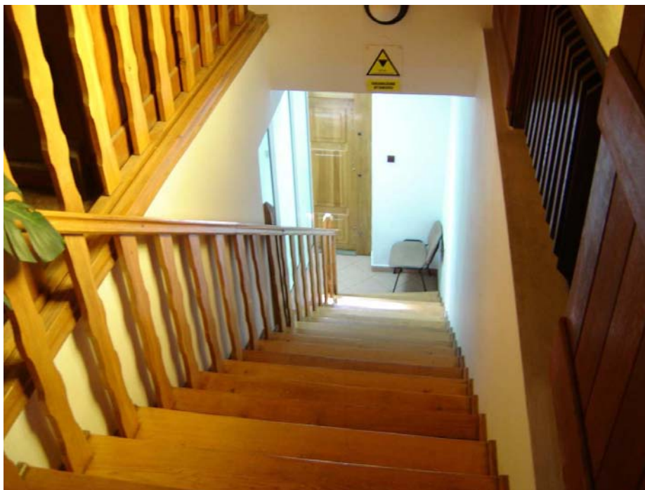
Widok na schody prowadzące z pomieszczenia (1.5) na piętro do hallu reprezentacyjnego.
