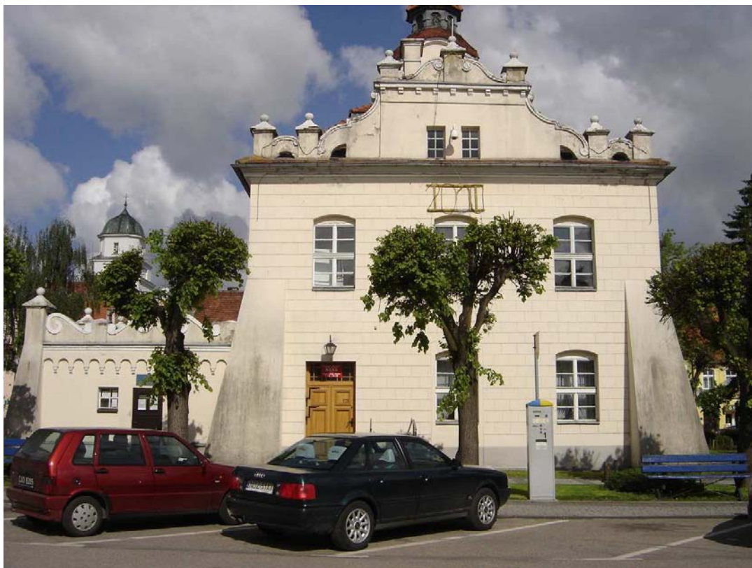
Elewacja zachodnia. Za drzwiami znajdują się proste schody prowadzące na piętro ratusza.
