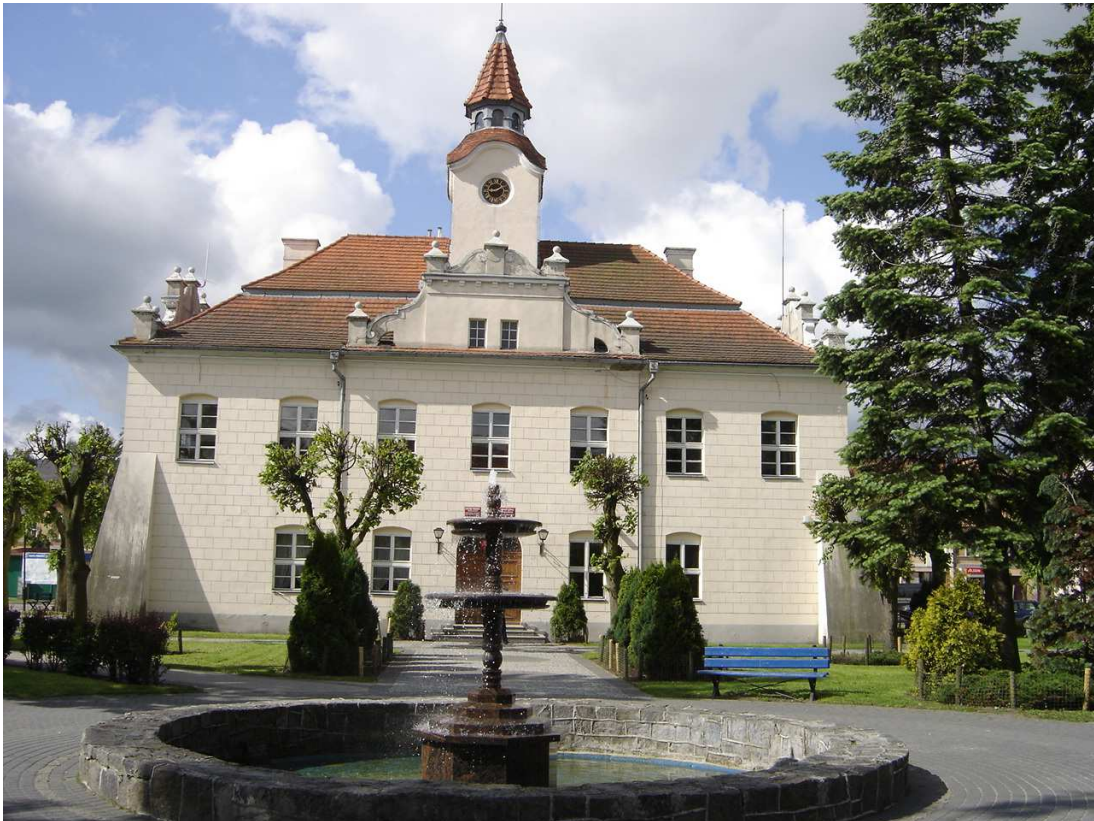
Elewacja północna ratusza. Po wejściu do hallu po lewej stronie znajduje się sala ślubów. Na piętrze z tej strony ratusza sale biurowe.
