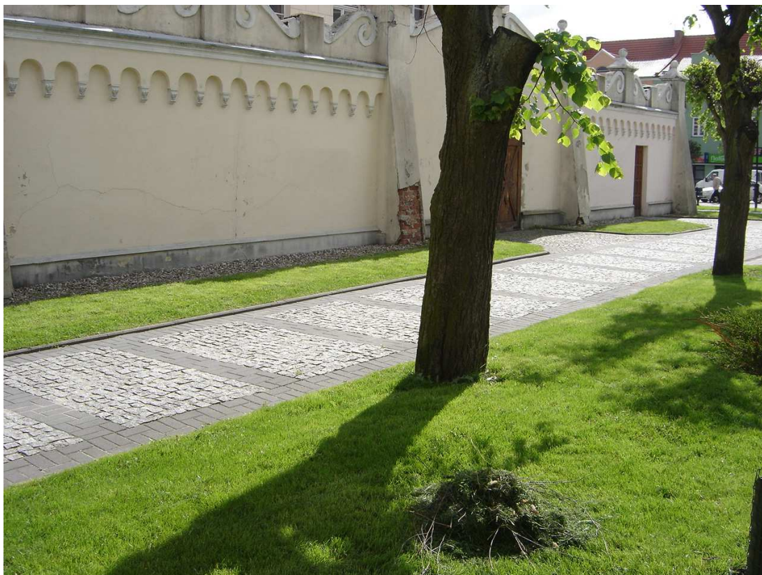
Widok na posadzkę rynku – kostka betonowa na przemian z kostką kamienną.
