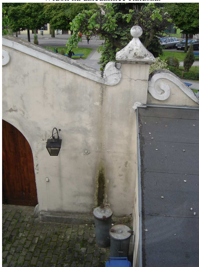
Widok z góry na budynek sanitariatów na parterze.
