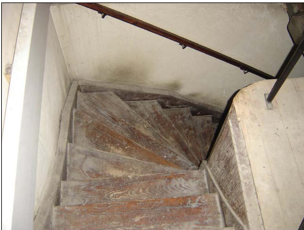
Widok na schody na poddasze z góry. Z prawej strony widoczny fragment XX-wiecznej obudowy
