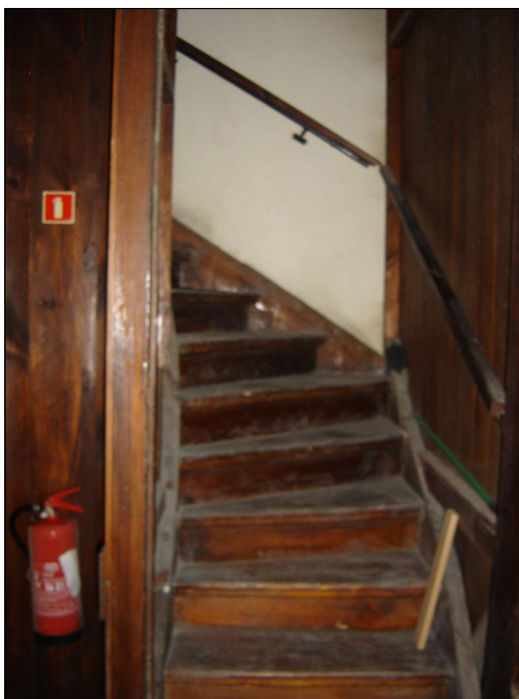
Schody prowadzące z korytarza na piętrze na poddasze – widok z korytarza.
