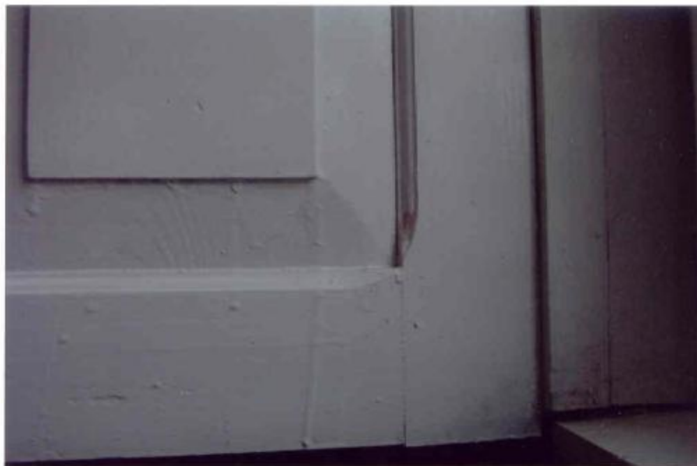
Fot. 51 Fragment okiennicy. Drewno oczyszczono dokładnie z wcześniejszych warstw malarskich. Na podstawie małych odkrywek w zagłębieniach profilowań i oceny powierzchni zewnętrznej stwierdzono, że na drewnie występuje tylko jedna warstwa farby.
