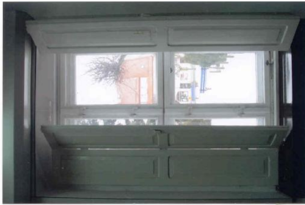
Fot.50 Okno wychodzące na wschód. Od strony wewnętrznej osadzono wtórnice drewniane okienne.
