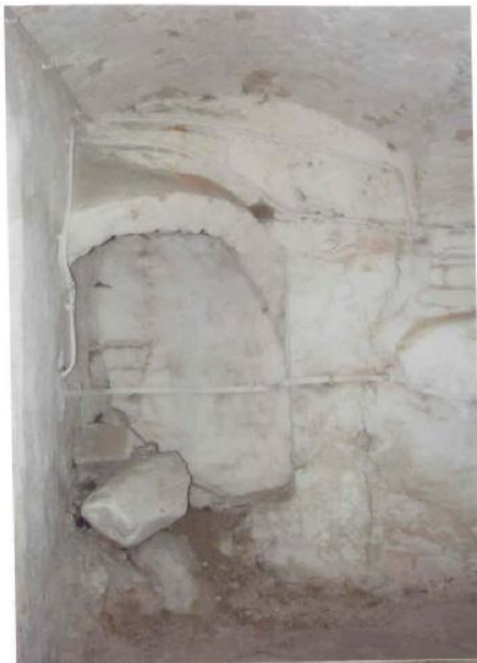
Fot.47 Przebudowany fragment korytarza piwnicznego
