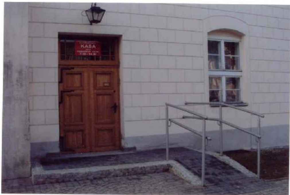
Fot. 32 Podjazd od strony południowej.
