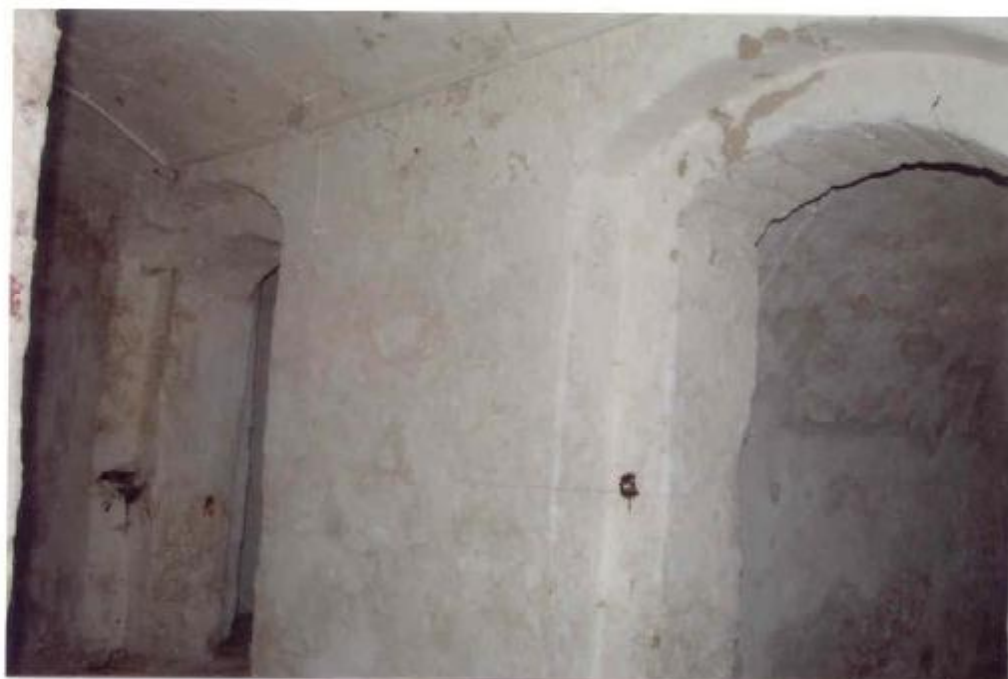
Fot. 44 Wejścia do poszczególnych pomieszczeń z korytarza piwnicznego
