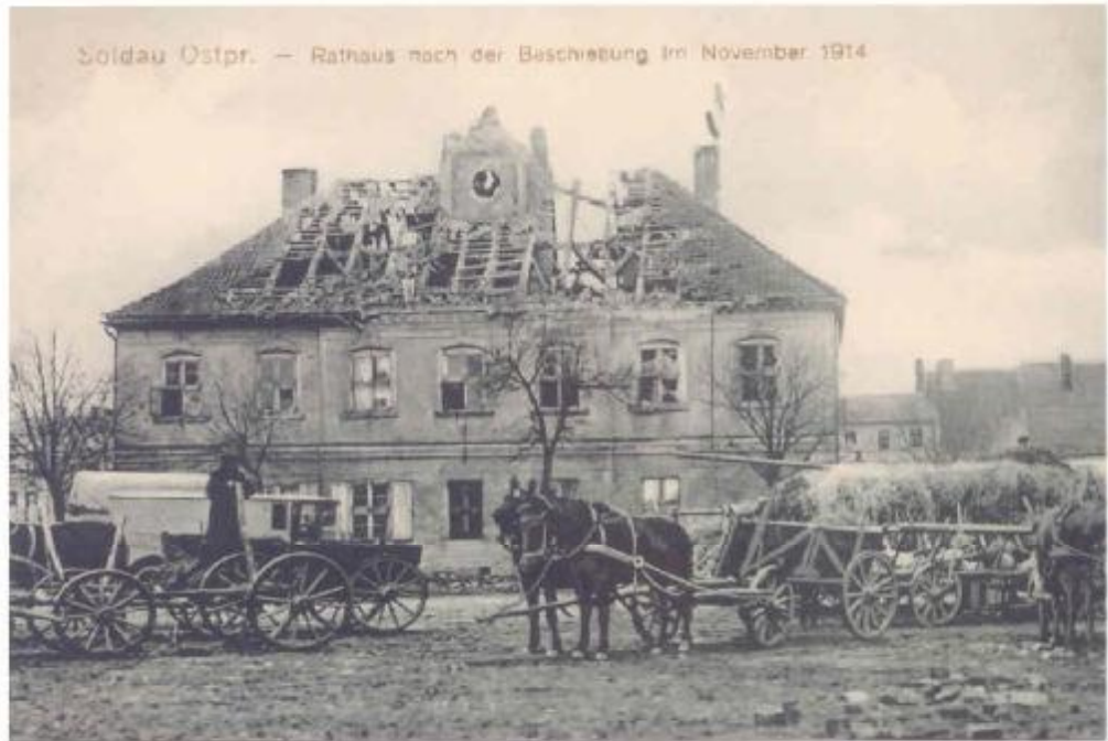
Fot. V Ratusz w listopadzie 1914 r. Po ataku Rosjan na Działdowo całkowitemu zniszczeniu uległa wieża i dach.
