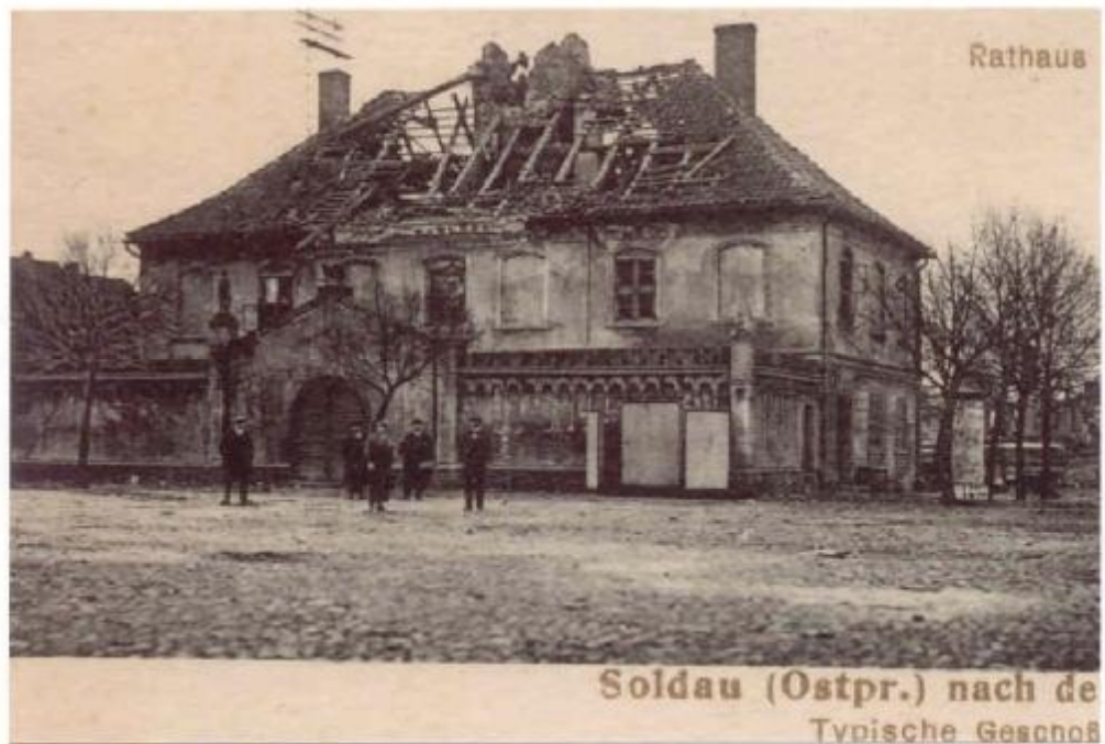
Fot. VI W 1914 roku wykuto w murze okalającym dziedziniec dwa nowe otwory drzwiowe – od strony Pd i Zach. Od strony Zach powstał szałet miejski, dlatego wejście przesłonięto parawanami. Widoczne też jest poziome deskowanie bramy głównej, co świadczy, że dzisiejsze drzwi pochodzą z lat dużo późniejszych (1922-23).
