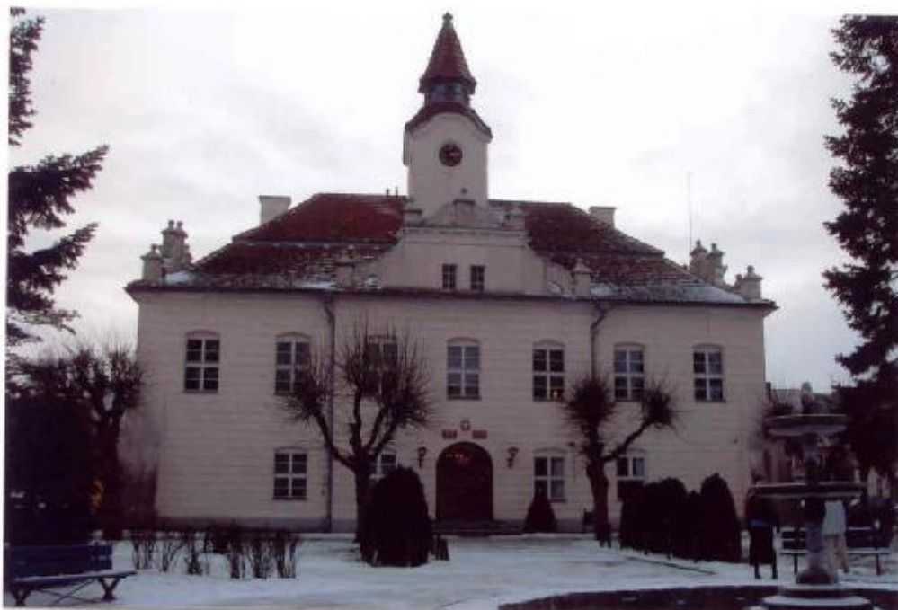
Fot. 1 Widok ogólny elewacji wschodniej.
