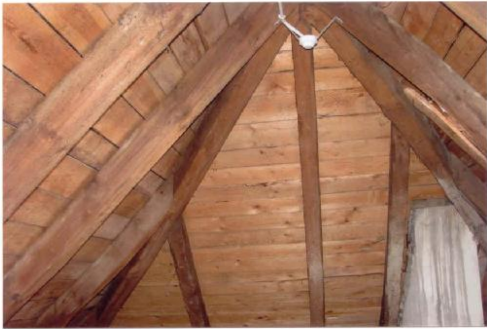
Fot. 63 Odeskowanie dachu jest bardzo dobrym stanie.
