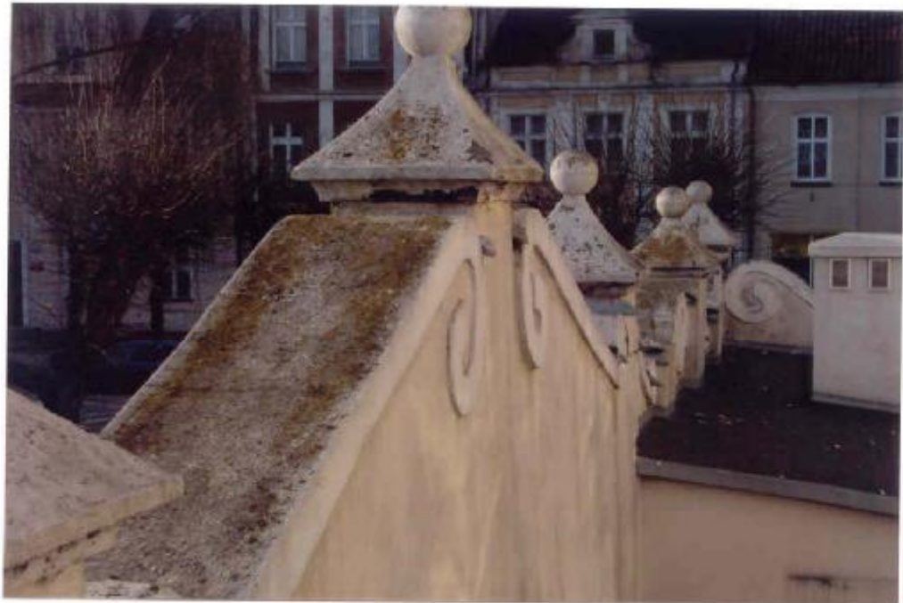
Fot. 23, 24 Liczne detale porośnięte są przez glony i grzyby. Sprzyja temu długie magazynowanie wilgoci przez mur.
