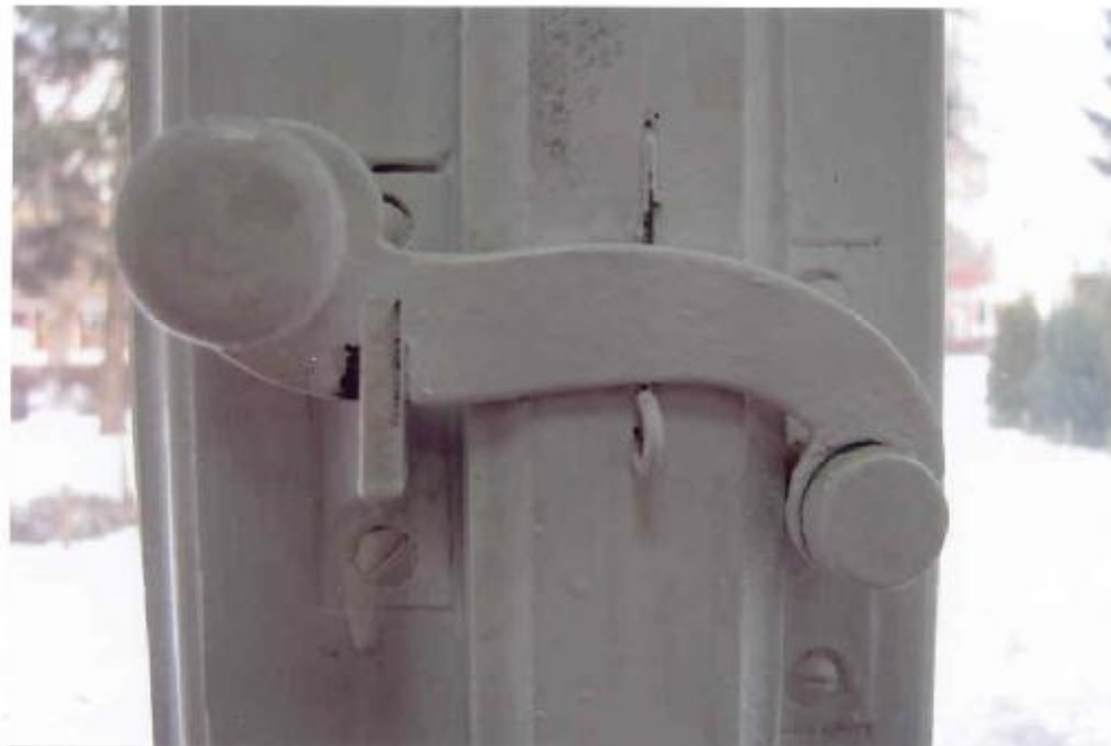
Fot. 52 Okna zamykane są na obartel.
