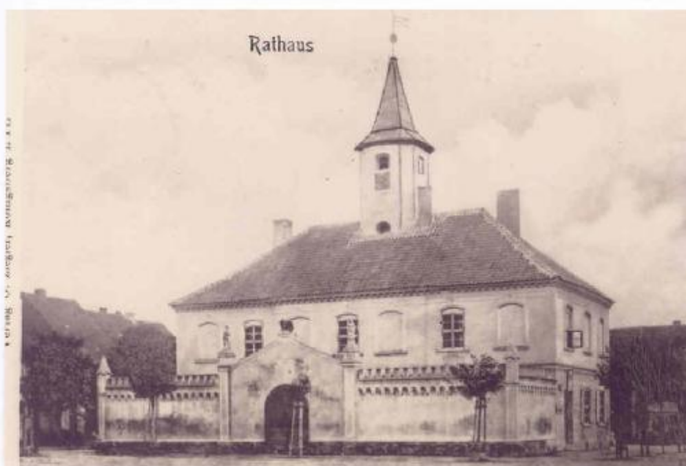
Fot. IV Wizerunek ratusza z przed 1914 r. Wieża ośmioboczna, kryta blachą. Dach kryty dachówką esówką. Tuż pod krawędzią dachu występuje fryz konsolowy, który później zniknął. Między oknami I piętra, a tym fryzem widoczna jest dekoracja wykonana w tynku. Nad każdą opaską okienną – medalion (rozeta?). Boniowanie tylko w strefie parterowej. Mur okalający dziedziniec zwieńczony blankowaniem, smukły kształt sterczyn. Brak innych otworów drzwiowych w murze poza bramą główną. Nad bramą stoją trzy rzeźby. Centralnie prawdopodobnie orzeł. Cokół muru kamienny, spoinowany.
