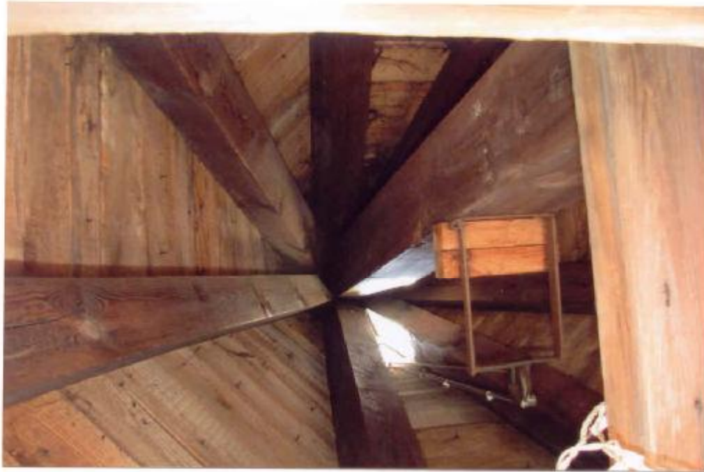
Fot. 70 Szczyt wieży ratusza. Stan zachowania bardzo dobry.
