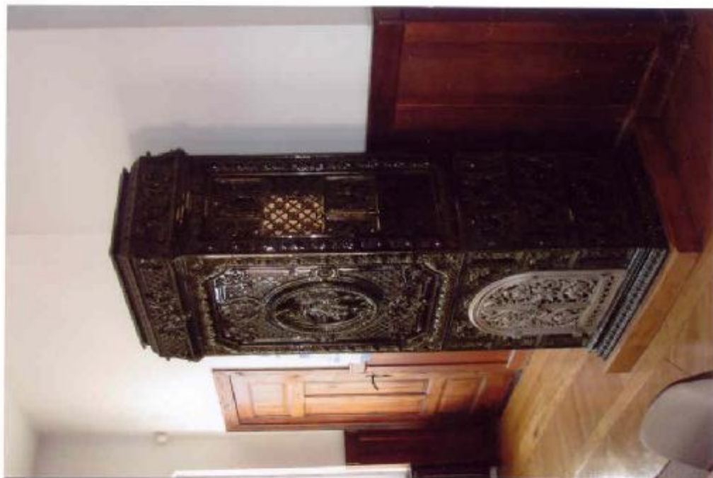
Fot. 59 i 60 Nieczynny, zabytkowy piec, stojący w sali na I piętrze. Poddawany był konserwacji, między innymi uzupełnianiu ubytków.
