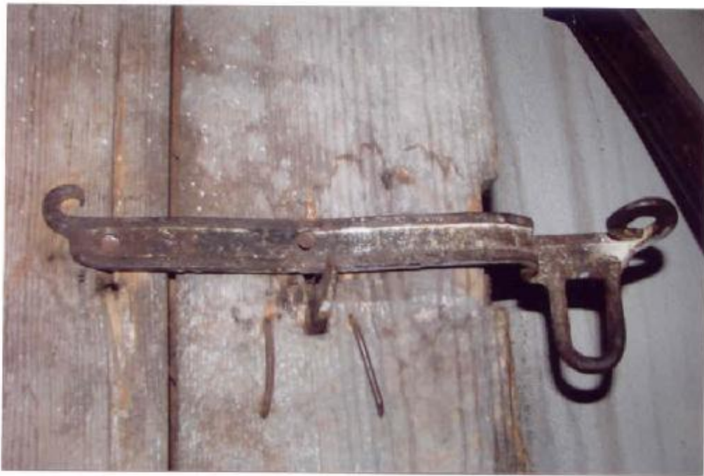
Fot. 65 Oryginalny skobel przybity do drzwi prowadzących na wieżę, do pomieszczenia z mechanizmem zegara.
