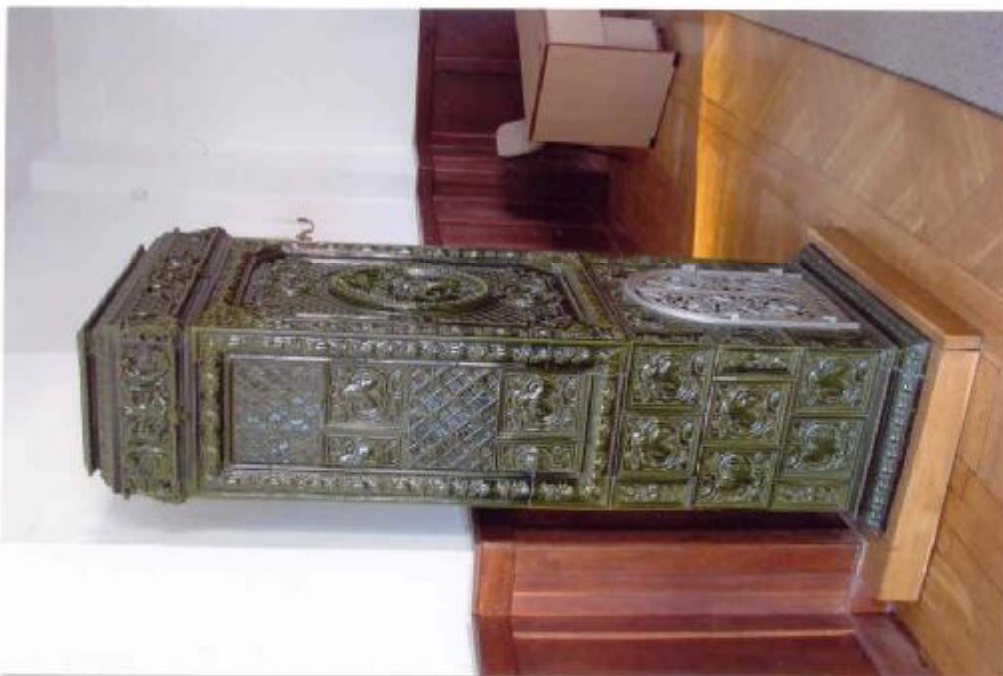
Fot. 59 i 60 Nieczynny, zabytkowy piec, stojący w sali na I piętrze. Poddawany był konserwacji, między innymi uzupełnianiu ubytków.
