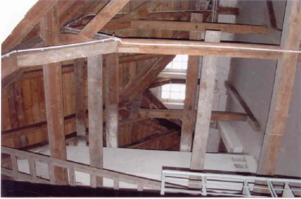
Fot. 61 i 62 Strych i więźba dachowa po ostatnim remoncie są w stanie niemal idealnym.
