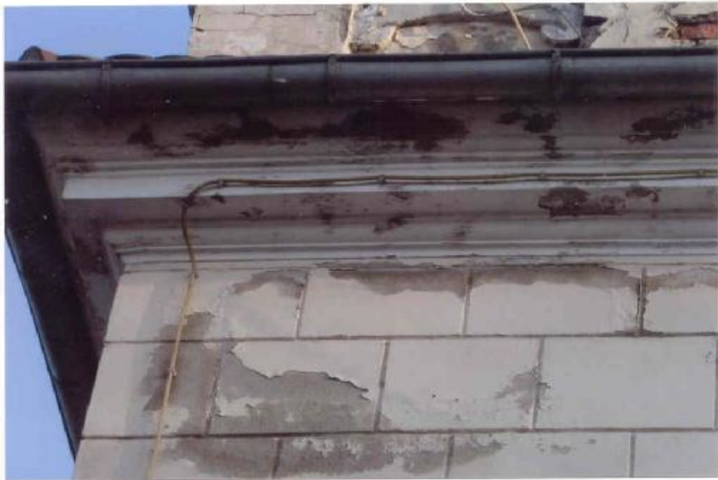
Fot.15 i 16 Farba złuszcza się ze wszystkich powierzchni.
