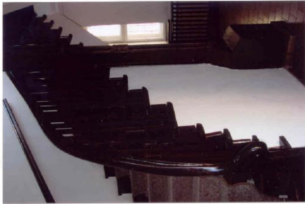
Fot. 53 i 54 Drewniane elementy klatki schodowej, a także ściany zostały dokładnie oczyszczone z wcześniejszych przemalowań w czasie remontu wykonywanego przez PKZ-y. Drewno zabezpieczono i polakierowano.
