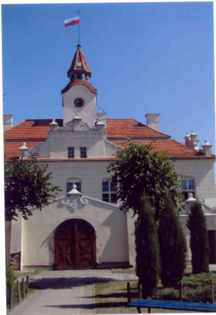
Fot.5 Elewacja zachodnia. Brama prowadząca na podwórze. Nad bramą widoczna jest rozeta.
