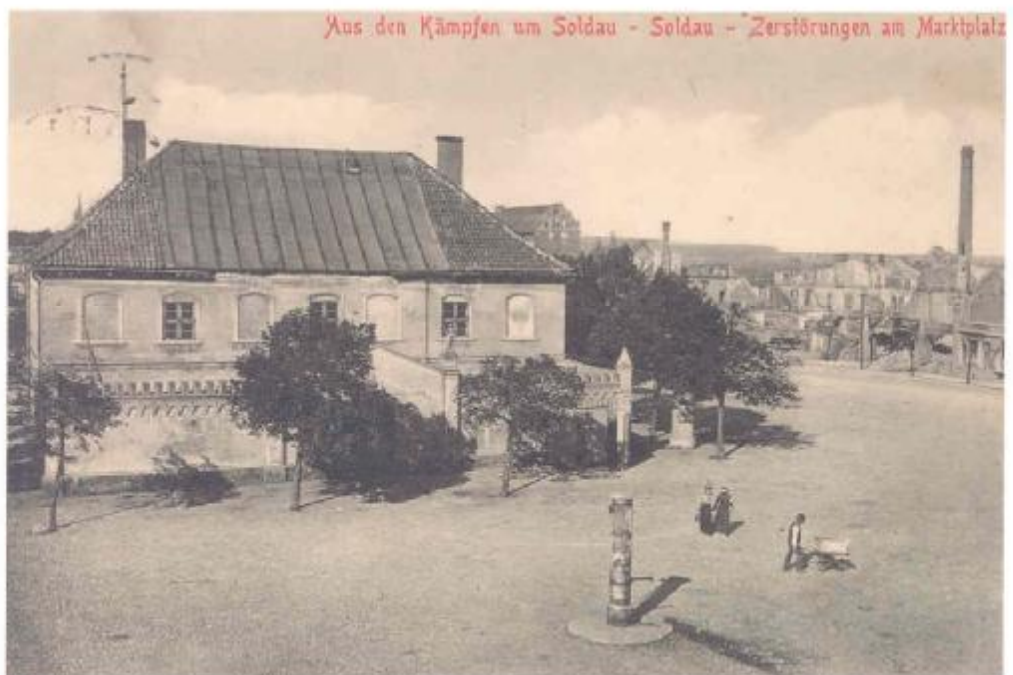
Fot. VII i VIII Naprawiony w 1915 r. dach. Na pierwszym piętrze elewacji Zach. co drugie okno występowała blenda. Widoczne zniszczenia fryzu i gzymsu poddachowego.
