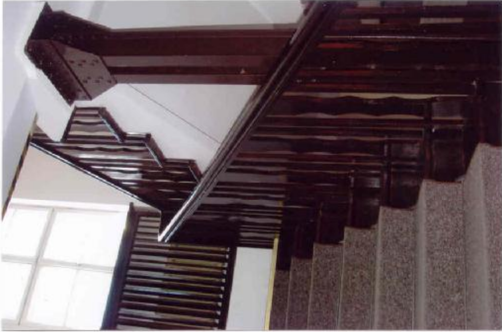
Fot. 53 i 54 Drewniane elementy klatki schodowej, a także ściany zostały dokładnie oczyszczone z wcześniejszych przemalowań w czasie remontu wykonywanego przez PKZ-y. Drewno zabezpieczono i polakierowano.
