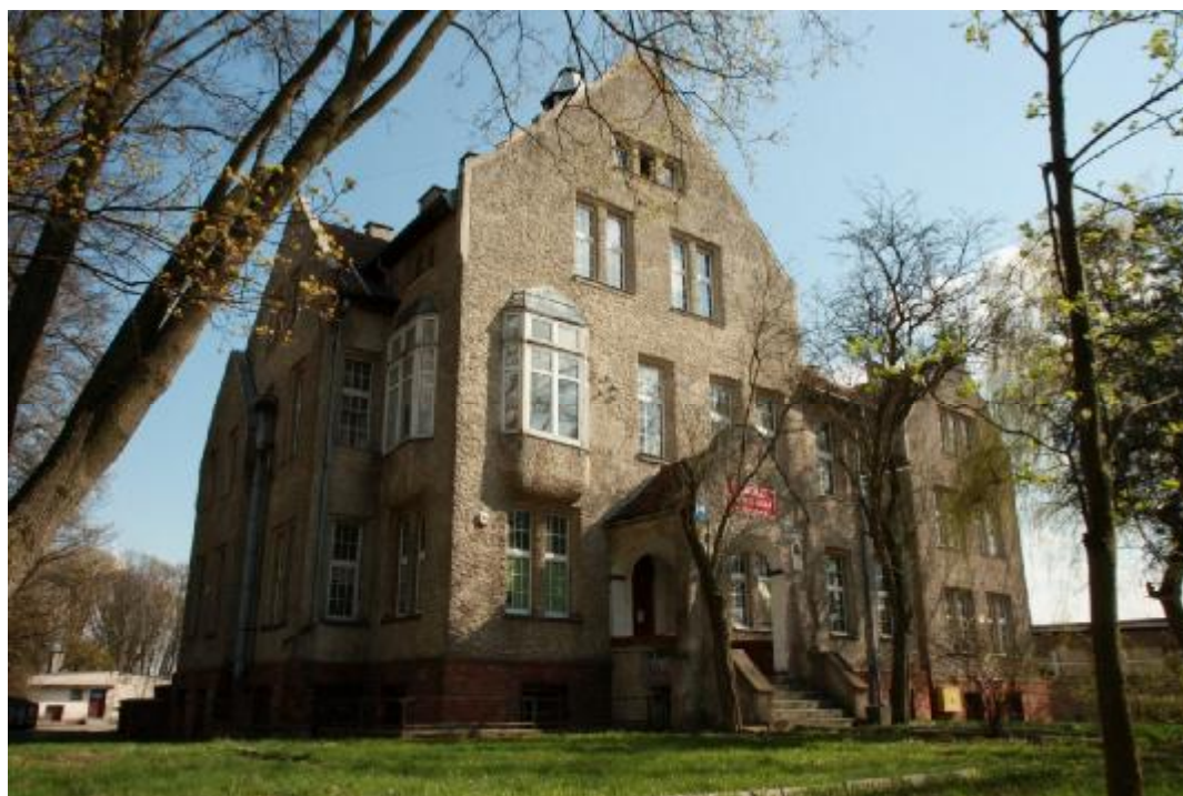
Fot. 5,6 Widok ogólny elewacji frontowej- północno – zachodniej.
