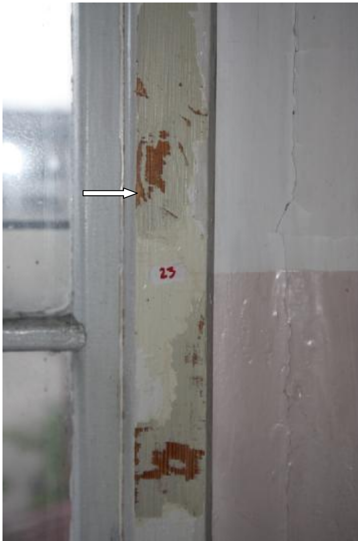
Fot. 134 Odkrywka na oknie. Zaznaczono miejsce pobrania próbki 23
