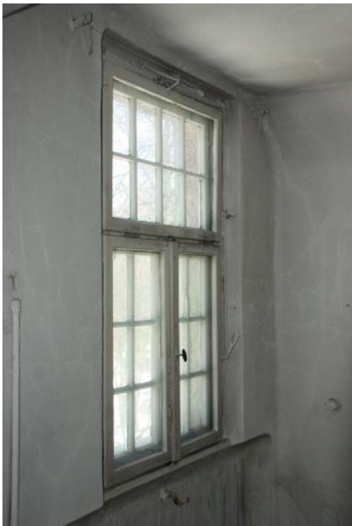
Fot.46 Oryginalne okno z mechanizmem uchylającym górne skrzydło, na parterze, w Sali od strony Pn-Wsch.
