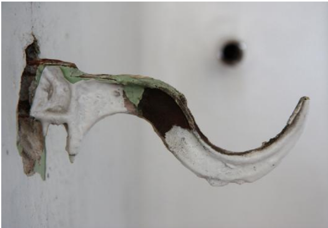
Fot. 49 Jeden z oryginalnych haków podtrzymujących zdemontowane już i usunięte kaloryfery.
