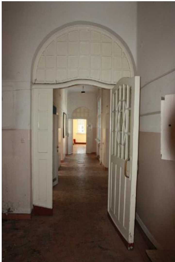
Fot. 50 Drzwi prowadzące z hallu na korytarz głównego skrzydła na parterze budynku.
