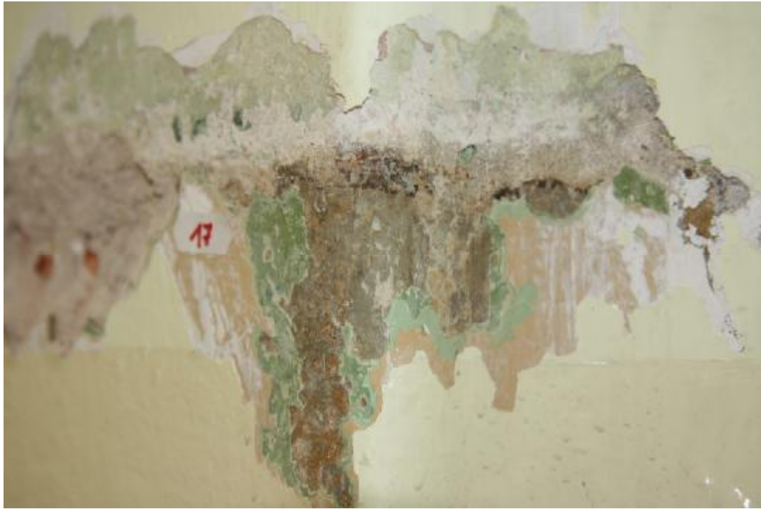
Fot. 117 Odkrywka i miejsce pobrania próbki 17. Widoczna czerwona linia ograniczająca lamperię.
