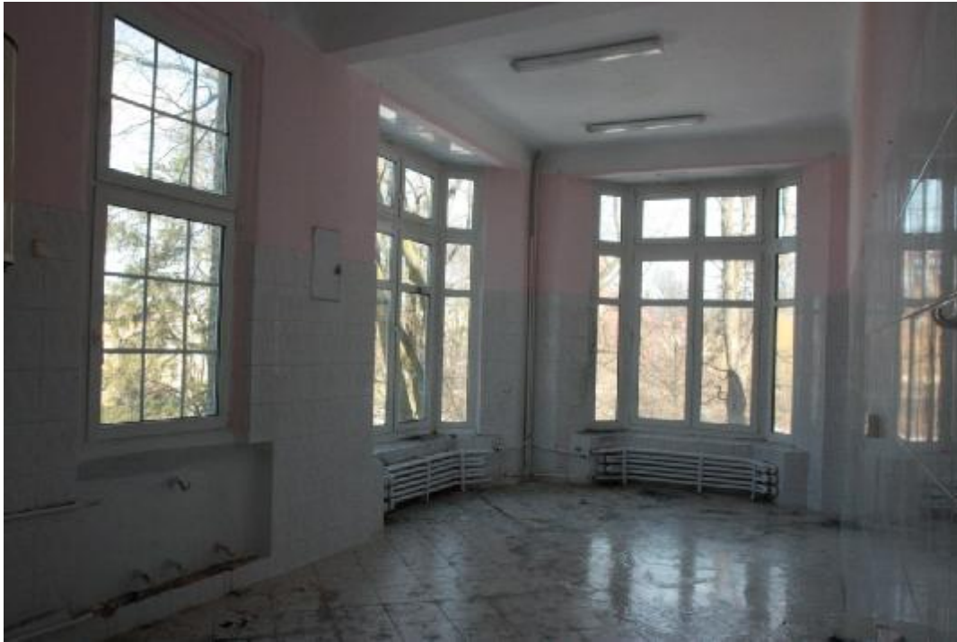
Fot. 48 Całkowicie zmodernizowana sala na I piętrze (sala z wykuszem), od strony frontowej (Pn-Zach.) i Pn-Wsch. Wszystkie okna wymieniono na okna z PCV, na podłodze i ścianach współczesne płytki ceramiczne.
