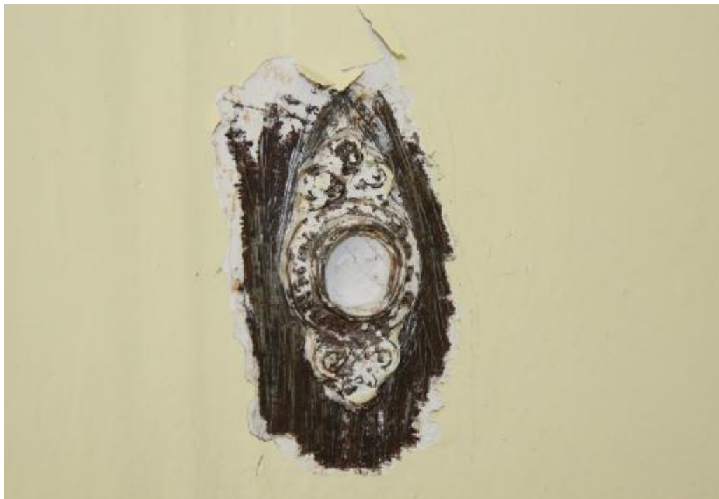
Fot. 56 Oryginalny szyldzik zamka na drzwiach zamykających szyb windy kuchennej. Drzwi także wykonane są z metalu. Otwór po kłamce wypełniony gipsem.
