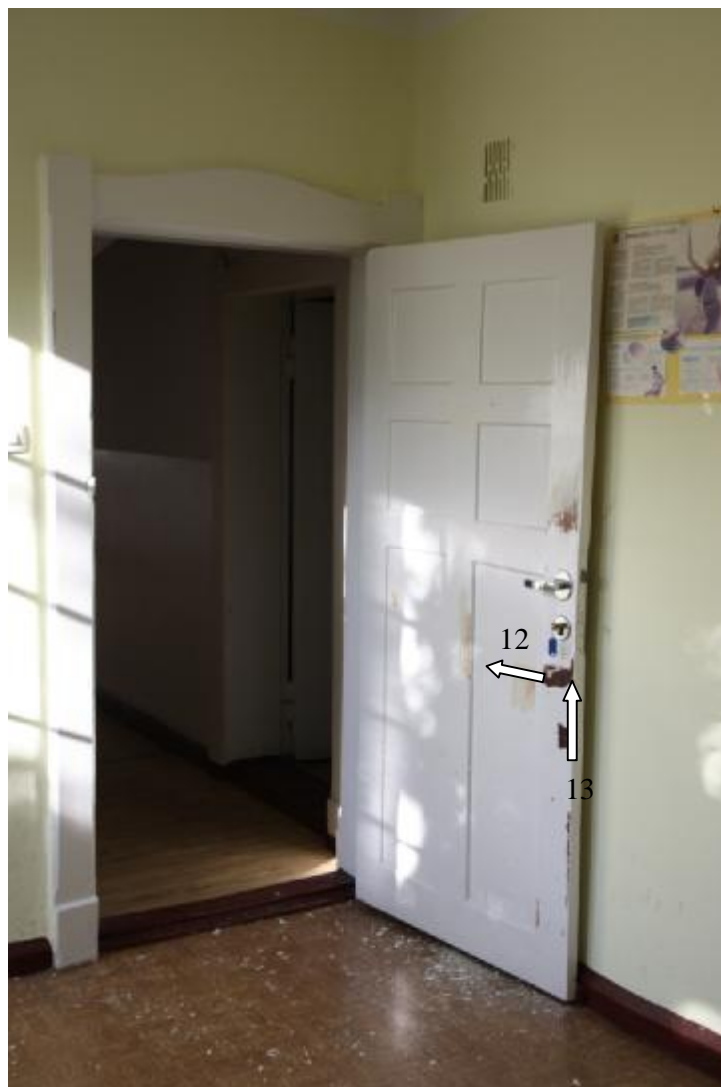
Fot. 102 Drzwi do sali w końcu korytarza, w głównym skrzydle, na II piętrze. Zaznaczono miejsca pobrania próbek 12 i 13. Próbkę 14 pobrano z drewnianego obramienia tych drzwi, z przeciwnej strony.
