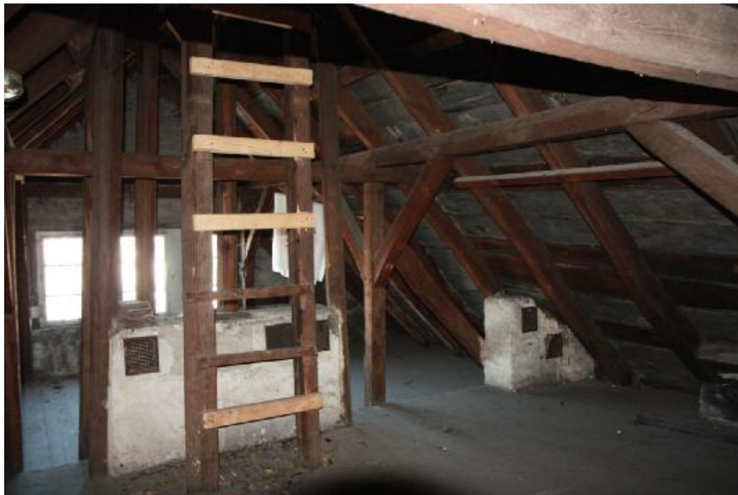
Fot. 74 Wnętrze strychu. Na pierwszym planie drabina prowadząca na wieżyczkę.
