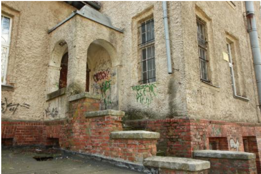
Fot. 18 Fragment elewacji północno – wschodniej. Mały ganek z bocznym wejściem do budynku.
