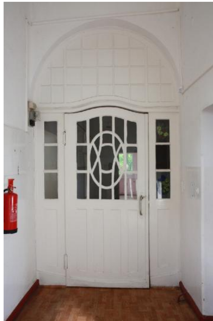
Fot. 51 Drzwi dzielące korytarz głównego skrzydła i przestrzeń klatki schodowej na II piętrze.
