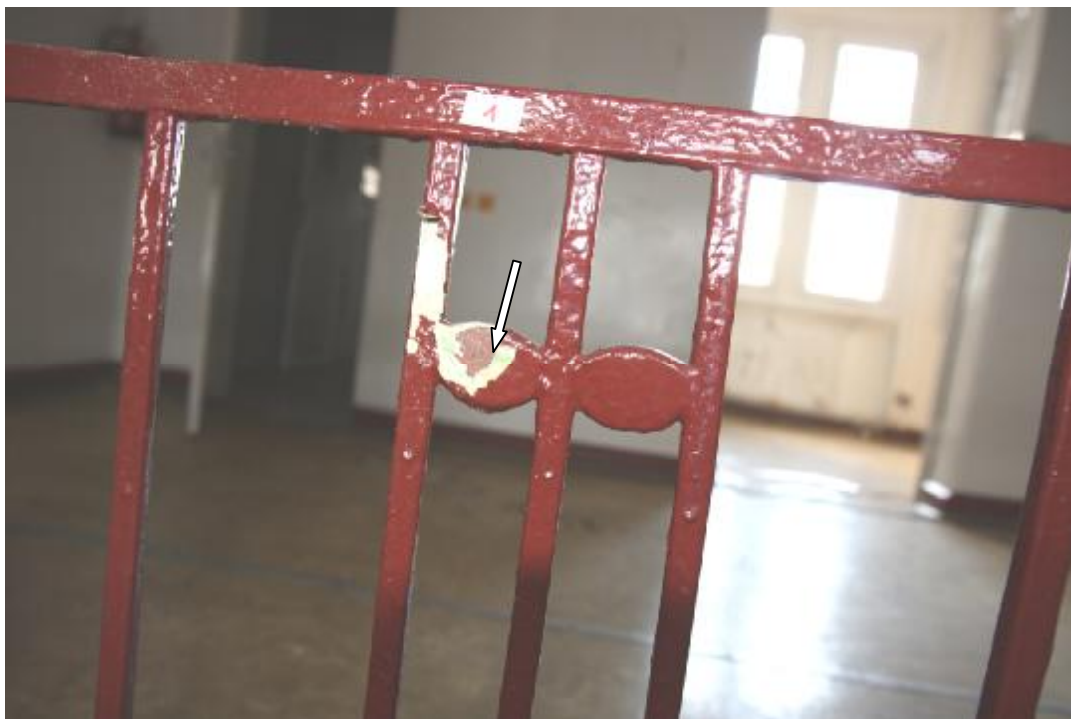
Fot. 78 Fragment balustrady na II piętrze głównej klatki schodowej. Wykonano odkrywkę i zaznaczono miejsce pobrania próbki 1.
