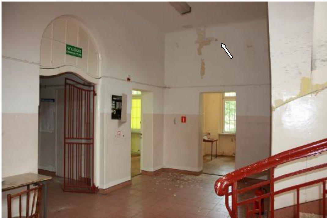
Fot. 136 Główny hall przy wejściu. W głębi, na ścianie widoczna odkrywka.
