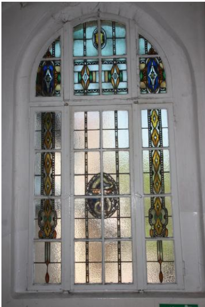
Fot. 38,39 W całości oryginalne okno z witrażem na pierwszym półpiętrze głównej klatki schodowej. W witrażu dominują motywy geometryczne. W centralnym miejscu umieszczono wizerunek węża Eskulapa. Witraż zachowany jest dobrym stanie. Posiada tylko niewielkie ubytki i pęknięcia.
