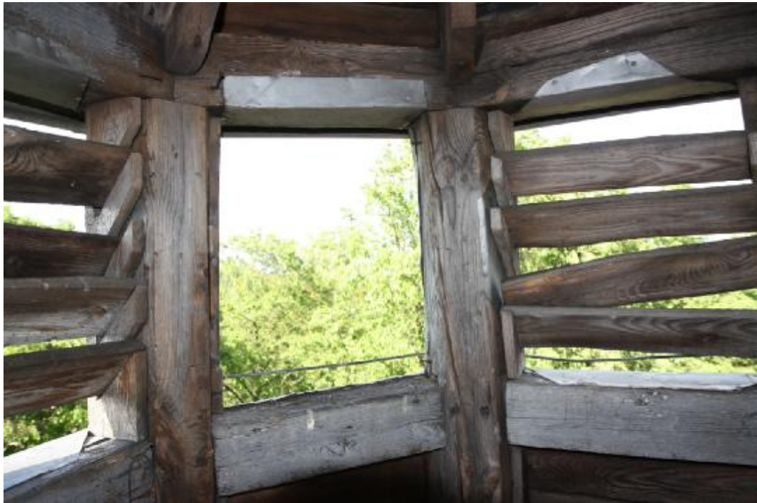
Fot. 76 Fragment drewnianej wieżyczki.
