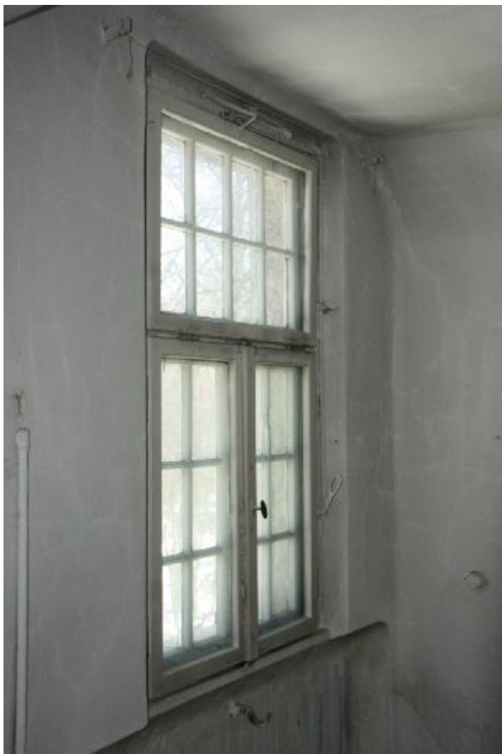
Fot.46 Oryginalne okno z mechanizmem uchylającym górne skrzydło, na parterze, w Sali od strony Pn-Wsch.
