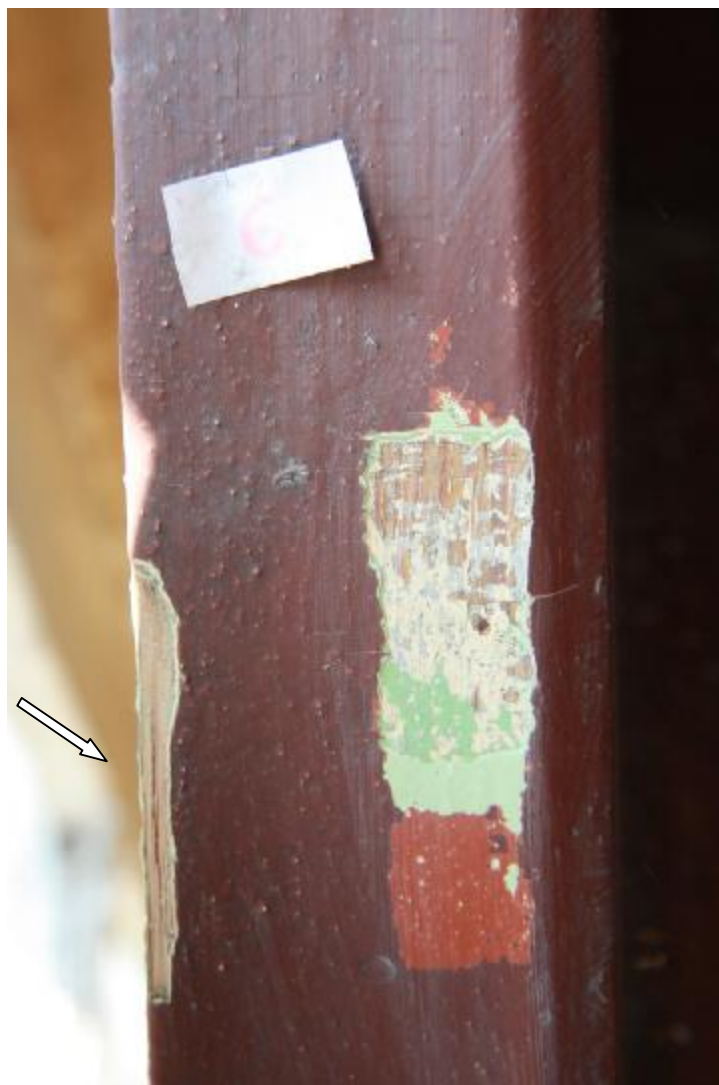
Fot. 90 Odkrywka na policzku schodów prowadzących na strych. Zaznaczono miejsce pobrania próbki 6. Na odkrywce można zaobserwować, że najwcześniejszą warstwą malarską jest biało-beżowa, a bezpośrednio na niej widać resztki warstwy błękitnej, której nie zarejestrowano na zdjęciu mikroskopowym. Kolejne przemalowania były zielone, w kolorze sieni i brązu.
