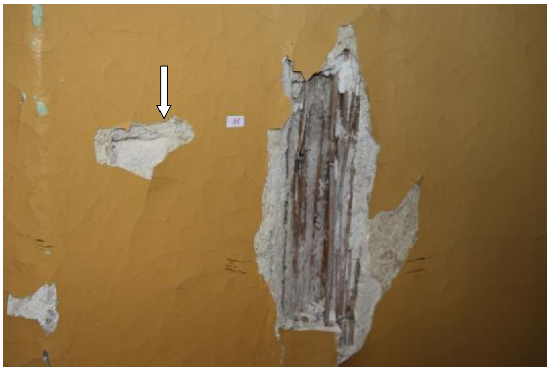
Fot. 100 Odkrywka na lamperii przy schodach prowadzących na strych. Zaznaczono miejsce pobrania próbki 11. Pod tynkiem widoczne oryginalne, pionowo ułożone, zbrojenie wykonane z trzciny.
