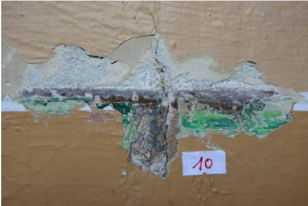
Fot.98 Miejsce pobrania próbki 10. Widoczna odsłonięta ciemnoczerwona linia ograniczająca lamperię. Ściana powyżej lamperii była kremowo-biała.
