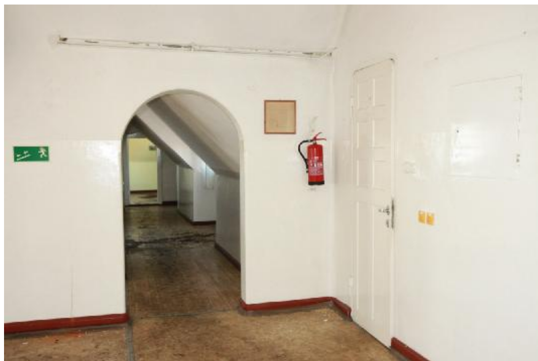
Fot. 55 Korytarz na II piętrze, główne skrzydło budynku.
