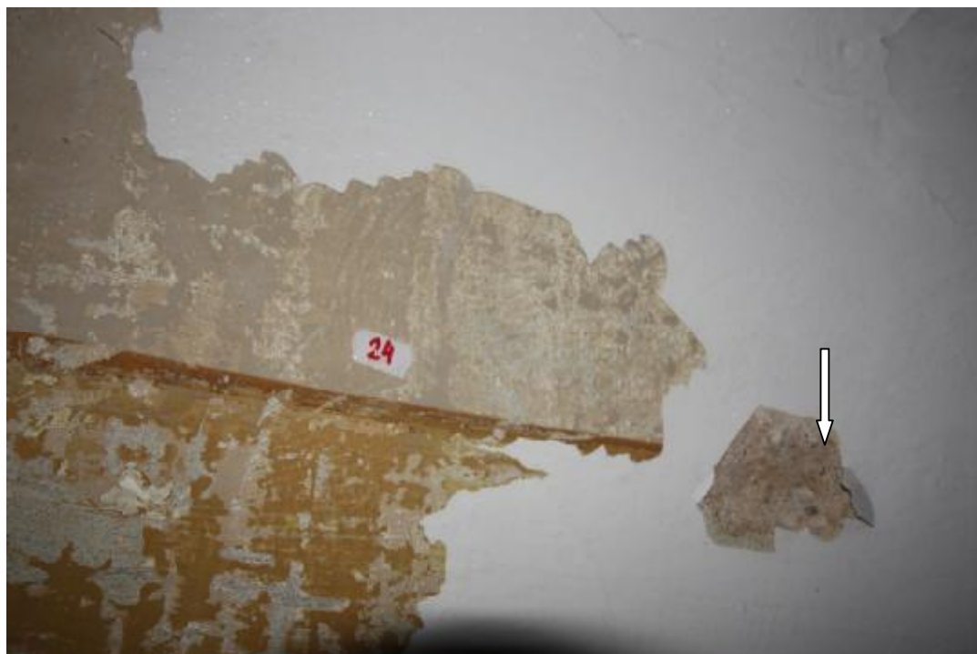
Fot. 137 Odkrywka na ścianie głównego hallu, tuż pod sufitem. Zauważyć można, że podział barwny ściany był urozmaicony poprzez wymalowanie poziomej, ciemnoczerwonej linii bardzo wysoko, około 50 cm pod sufitem. Ścianę poniżej linii wymalowano w kolorze oliwkowo-pomarańczowym, a powyżej biało-szarym..
