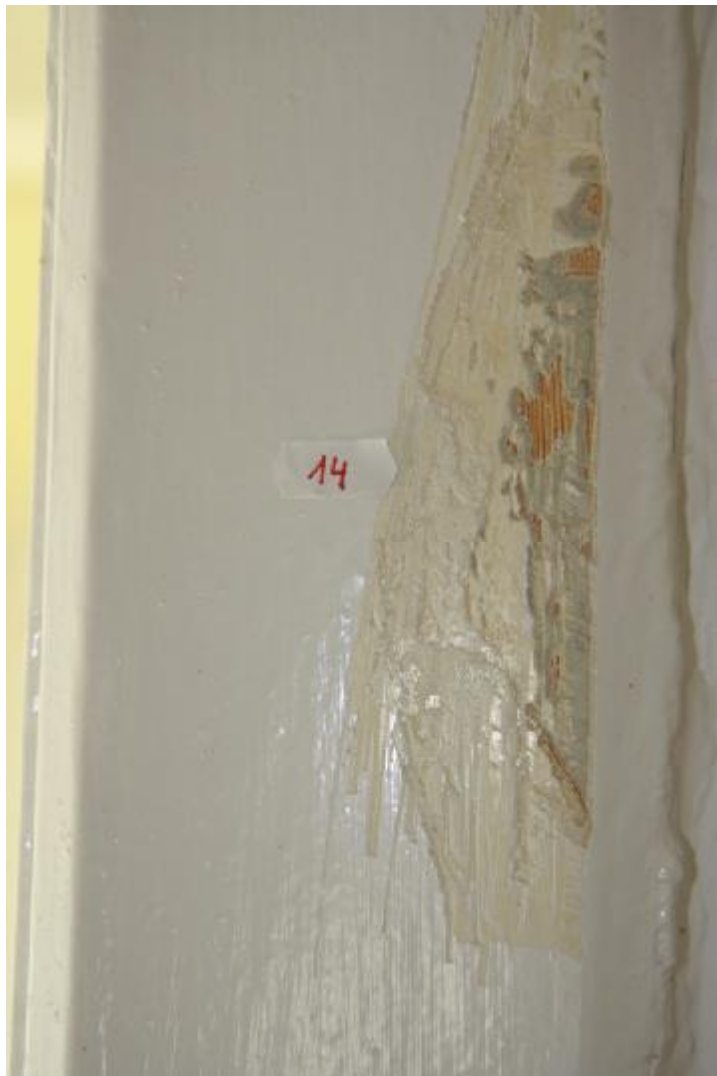
Fot.107 Odkrywka na obramieniu drzwiowym. W pobliżu odkrywki pobrano próbkę 14. Widoczna oryginalna warstwa jasnozielona.
