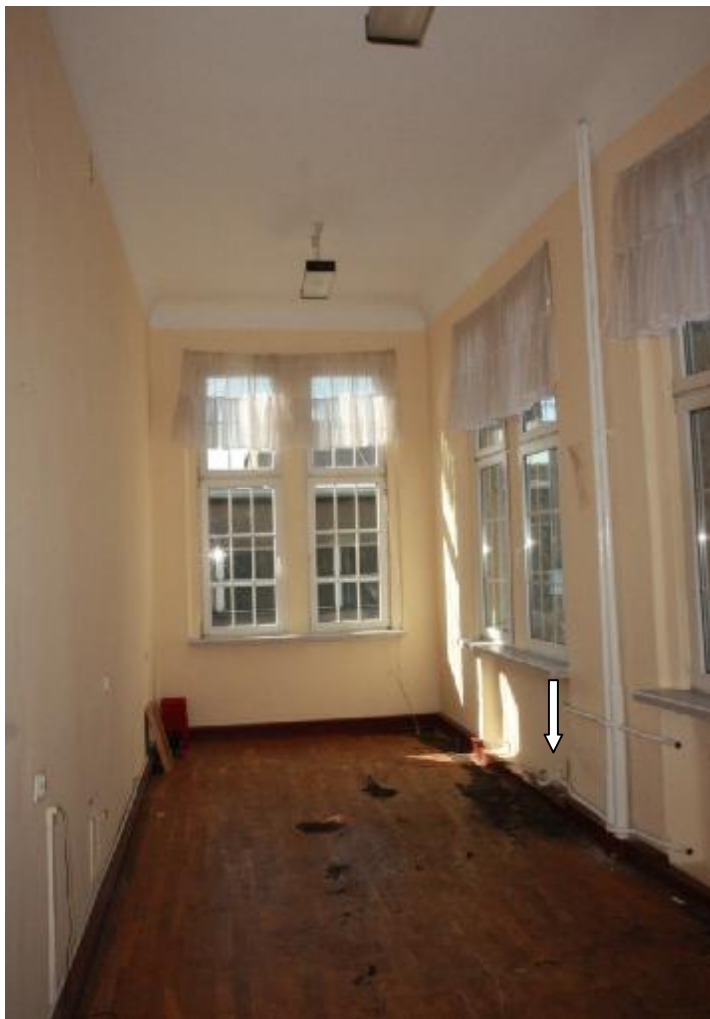
Fot. 116 Sala na I piętrze w głównym skrzydle, od strony Pn-Zach. Zaznaczono miejsce pobrania próbki z drewnianej listwy przypodłogowej.
