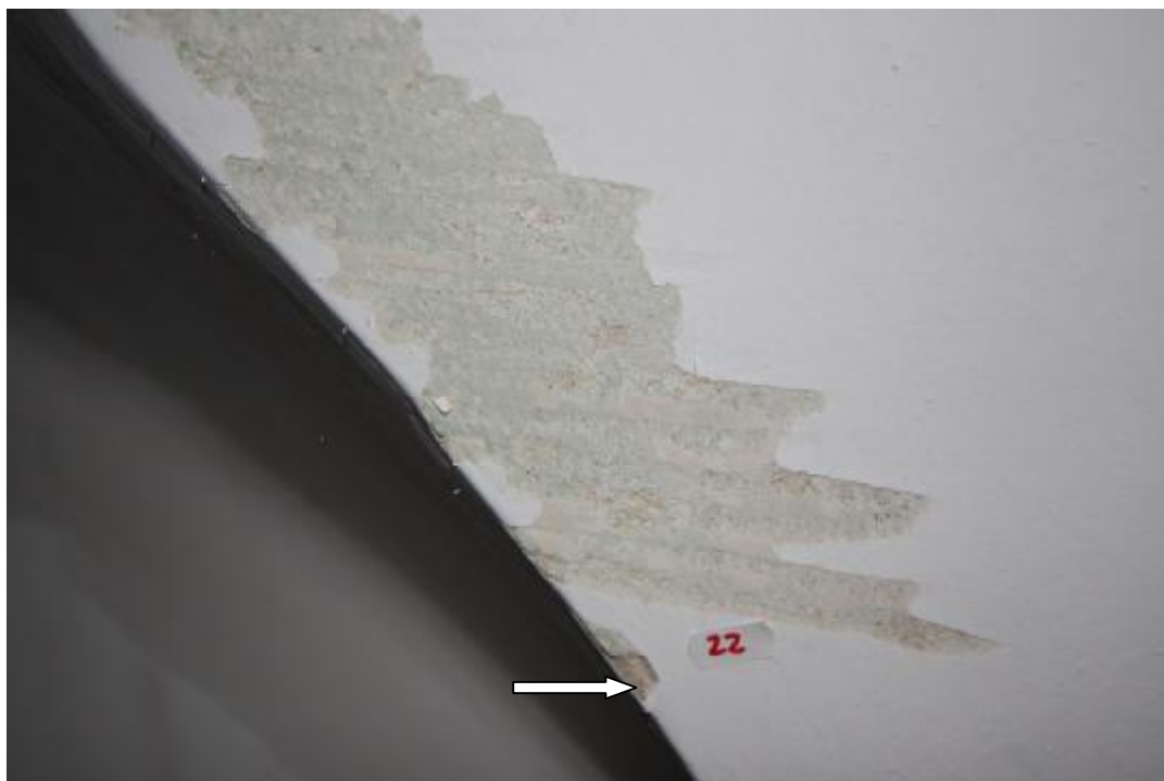
Fot 131 Fragment sklepienia w przedsionku głównego wejścia. Zaznaczono miejsce pobrania próbki 22.
