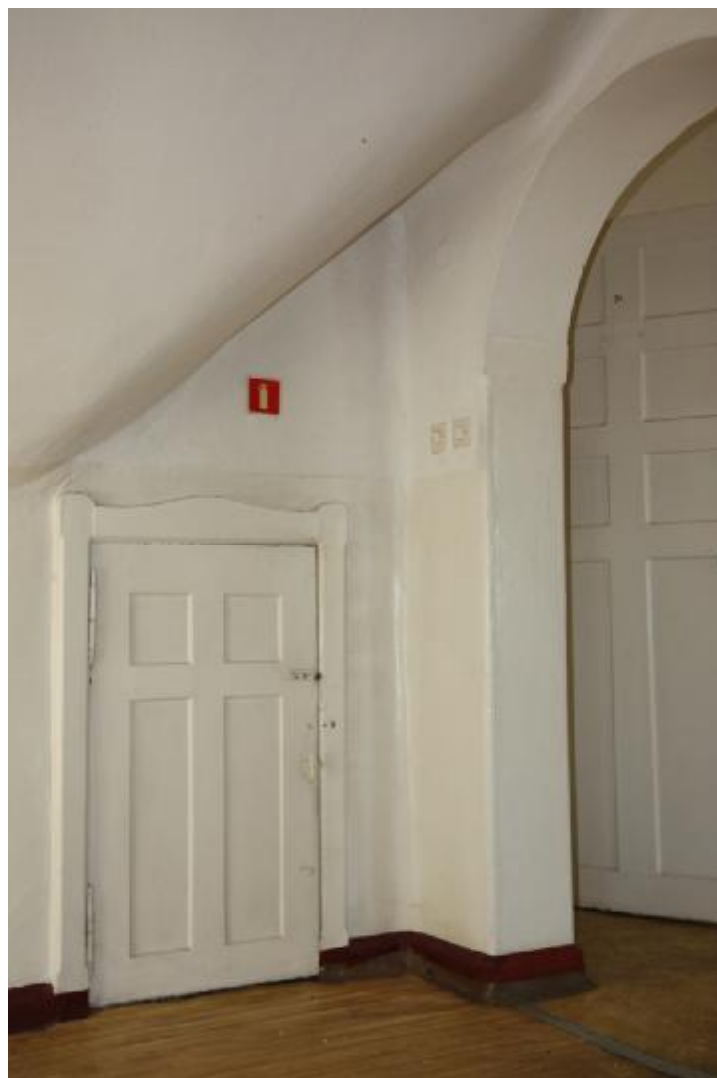
Fot. 54 II piętro w głównym skrzydle budynku. Małe drzwi prowadzące na nieużytkowe poddasze.
