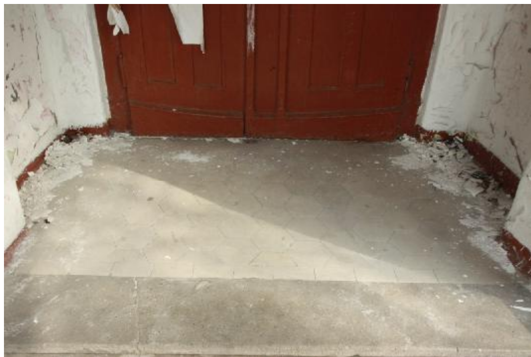
Fot. 126 Przed głównym wejściem zachowały się częściowo oryginalne sześcioboczne i prostokątne płytki ceramiczne.
