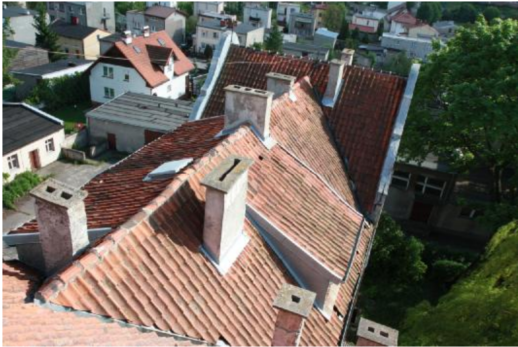
Fot. 15 Widok ogólny dachu głównego skrzydła budynku. Po prawej stronie znajduje się elewacja frontowa.
