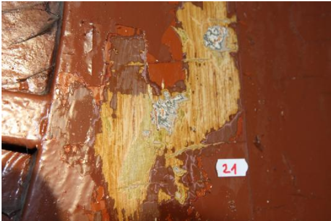
Fot. 129 Odkrywka na drzwiach frontowych. Pod warstwami wielu wtórnych przemałowań znajduje się wielobarwny mazerunek. Warstwę wierzchnią ma w kolorze oliwkowym. Zaznaczono miejsce pobrania próbki 21.
