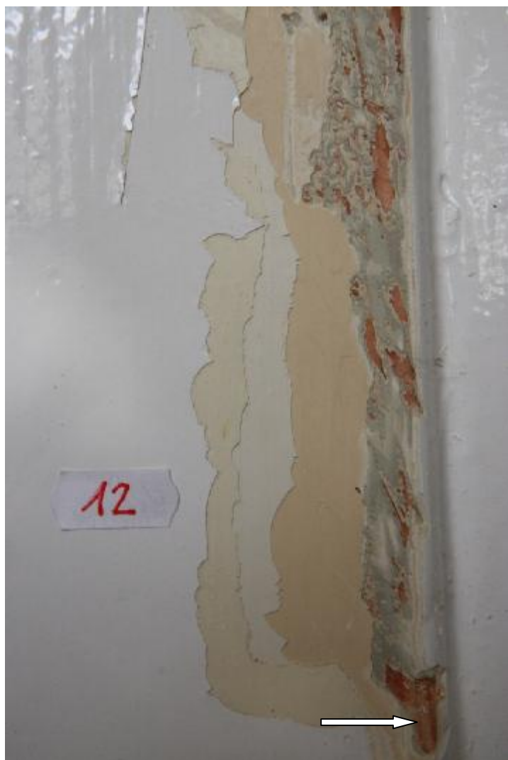
Fot. 103 Odkrywka wykonana na drzwiach. Zaznaczono miejsce pobrania próbki 12.
