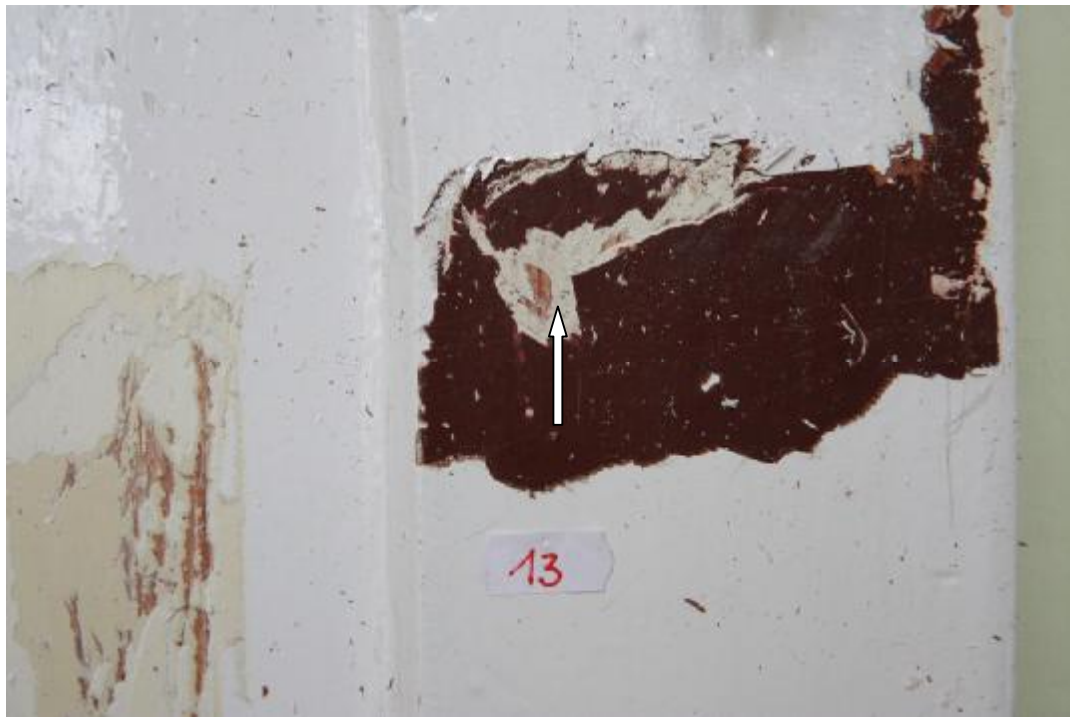
Fot. 105 Odkrywka wykonana na drzwiach, pod klamką. Całe drzwi oryginalnie pomalowane były na biało, potem jasnozielono, a następnie część ramiaka od strony klamek zamalowywano na kolor ciemnobordowy. Chroniono w ten sposób część drzwi, która była najbardziej narażona na zabrudzenia i obicia. Duży kontrast kolorów powodował, że łatwiej było dostrzec wejście.
