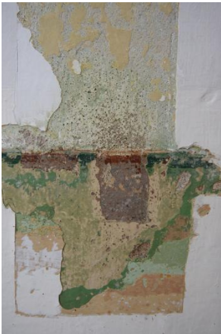
Fot.109 Korytarz na I piętrze. Zaznaczono miejsce na filarze, gdzie wykonano odkrywkę udokumentowaną na następnej fotografii.
