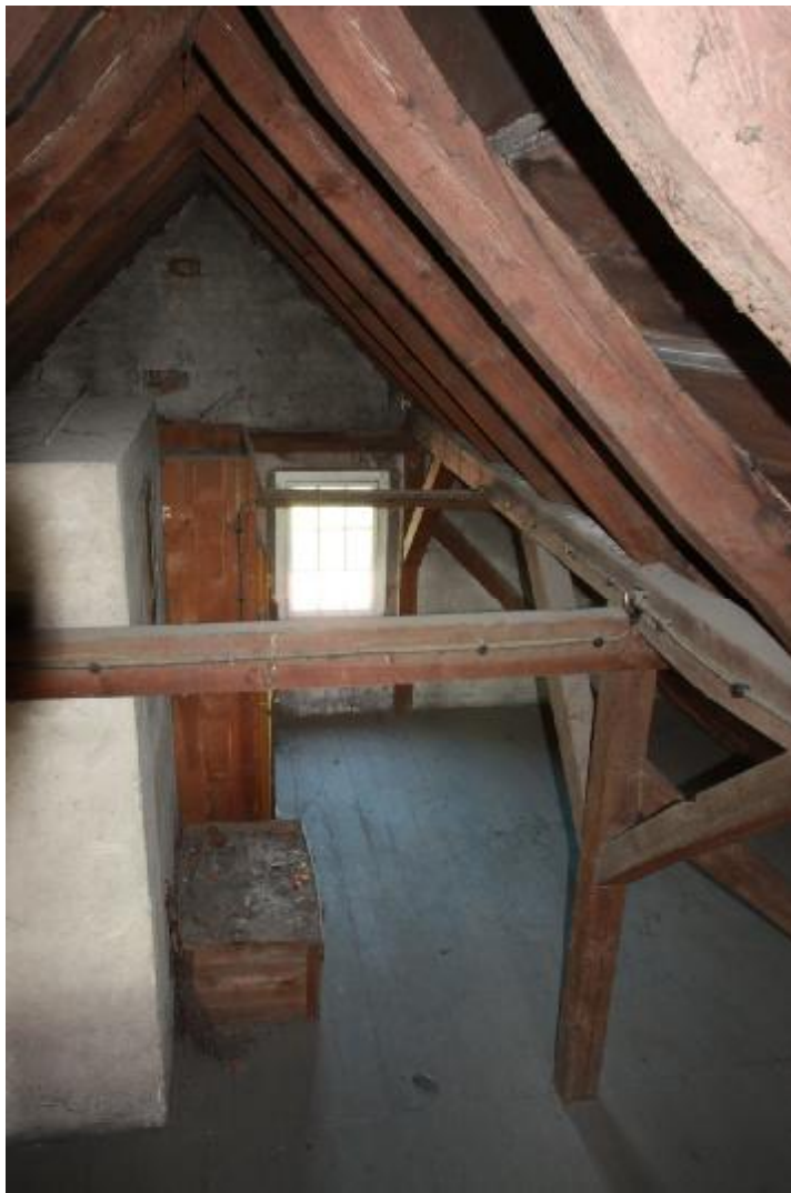
Fot. 72 Więżba dachowa zachowana jest w bardzo dobrym stanie.
