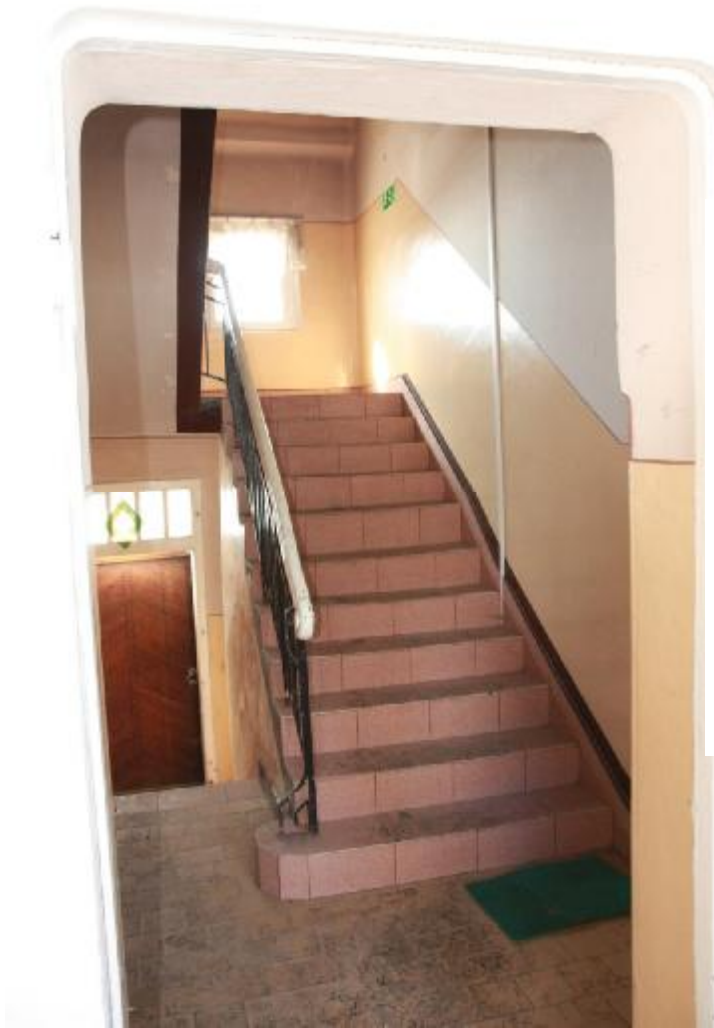
Fot. 66, 67 Widok na mniejszą klatkę schodową w mniejszym, Pd-Wsch. skrzydle budynku.
