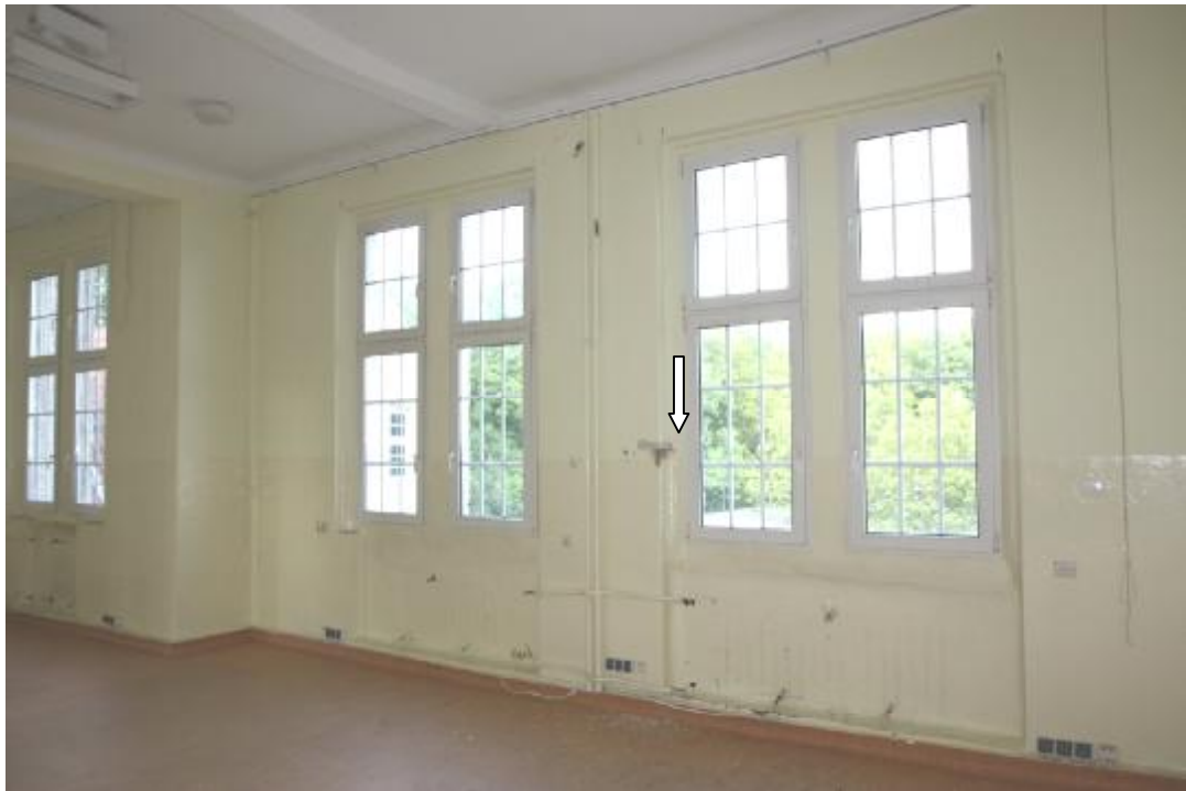
Fot. 115 Sala na I piętrze w głównym skrzydle, od strony Pd-Wsch. Zaznaczono miejsce pobrania próbki 17 i wykonania odkrywki na ścianie
