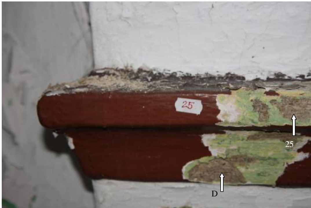
Fot. 139 Profil pilastra, na którym wsparty jest ganek głównego wejścia. Zaznaczono miejsce pobrania próbki 25 oraz D.
