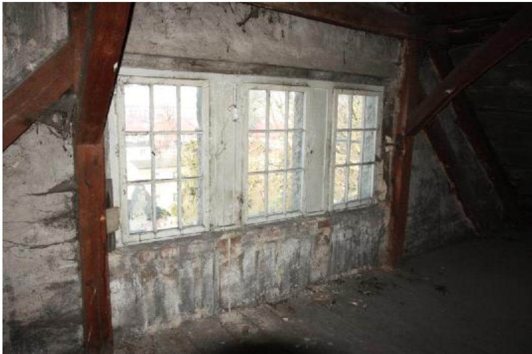
Fot. 73 Trzy oryginalne okna na strychu, na elewacji frontowej, są mocno zniszczone i nieszczelne.
