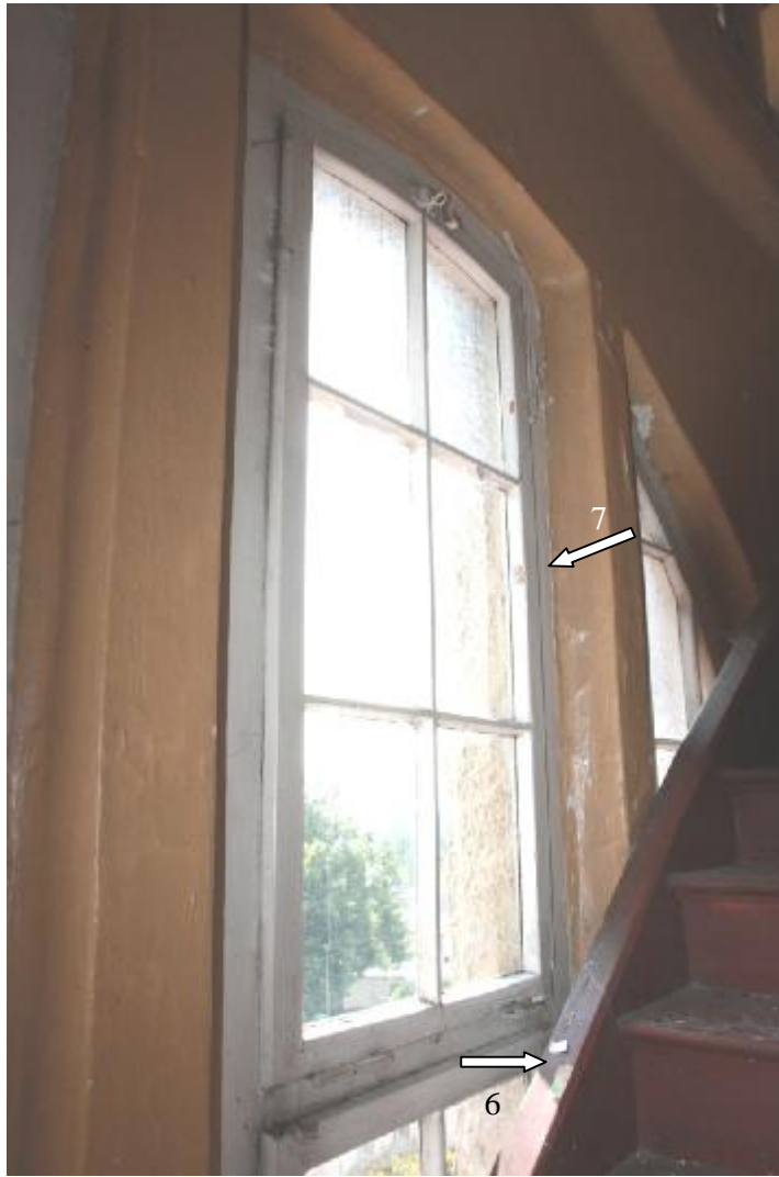
Fot. 84 Jedno ze skrzydeł (uchylne) oryginalnego, półkolistie zwieńczonego okna, przy schodach prowadzących na strych. Zaznaczono miejsce pobrania próbek 6 i 7.
