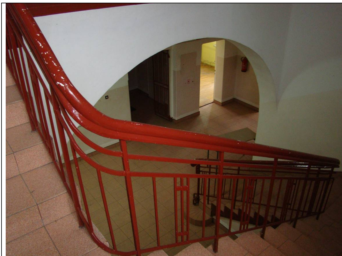
Widok z pierwszego biegu schodów na hol główny.
