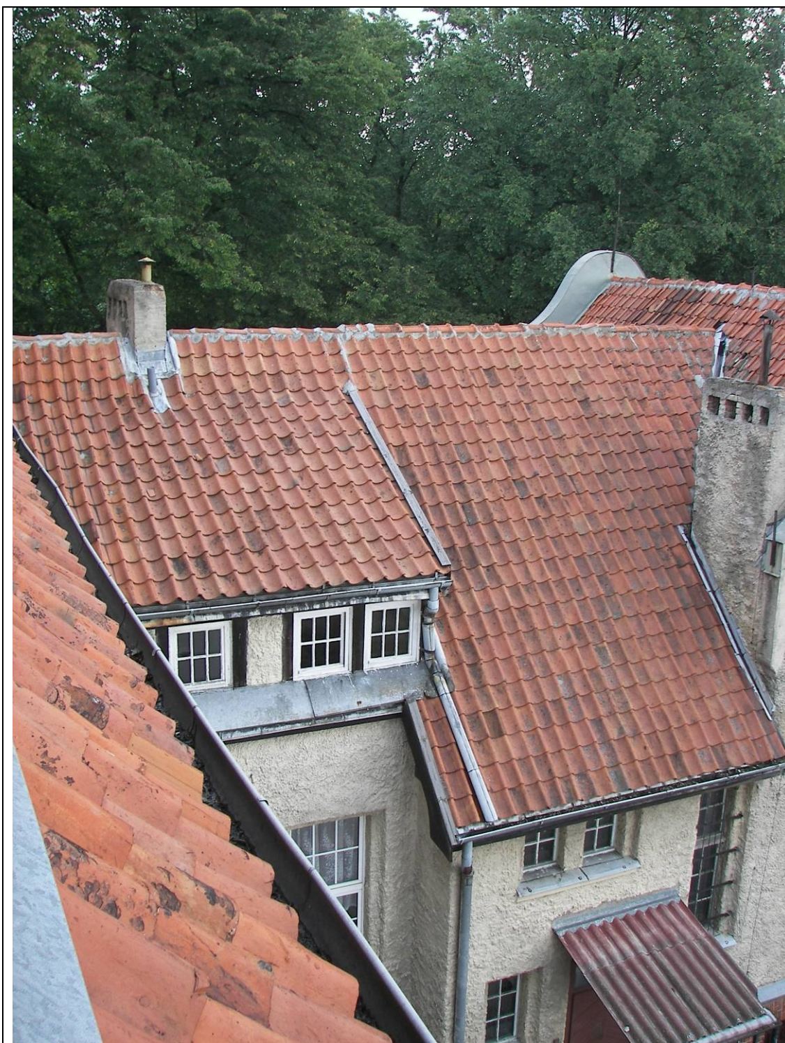
Widok dachu oficyny /skrzydła wschodniego/
