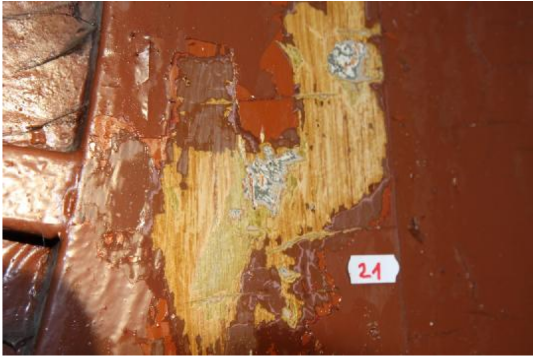
Fot. 129 Odkrywka na drzwiach frontowych. Pod warstwami wielu wtórnych przemalowań znajduje się wielobarwny mazerunek. Warstwę wierzchnią ma w kolorze oliwkowym. Zaznaczono miejsce pobrania próbki 21.
