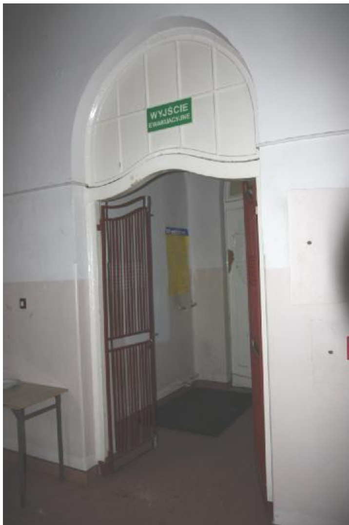
Fot. 119 Widok na przedsionek głównego wejścia. W miejscu, gdzie dziś jest krata kiedyś były przeszklone drzwi.
