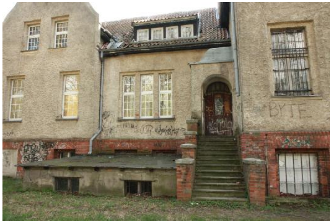
Fot. 19 Fragment elewacji Pn-Wsch. Przy schodach prowadzących na ganek wtórnie dobudowano pomieszczenie piwniczne. W ten sposób zasłonięto częściowo cokół i oryginalne otwory okienne. Na lewo od tej przybudówki zamurowano skrajny otwór okienny w piwnicy. Brak właściwego odprowadzenia wody opadowej jest przyczyną znacznych zniszczeń muru jakie wystąpiły z tej strony.
