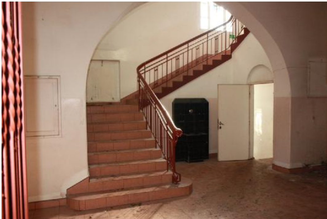
Fot. 58 Główny hall na parterze. W głębi widoczne ujęcie wody pitnej.
