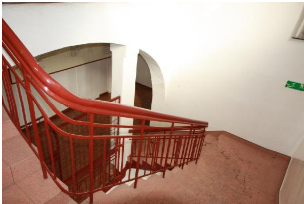
Fot. 62, 63 Bieg schodów głównej klatki schodowej na I i II piętro.
