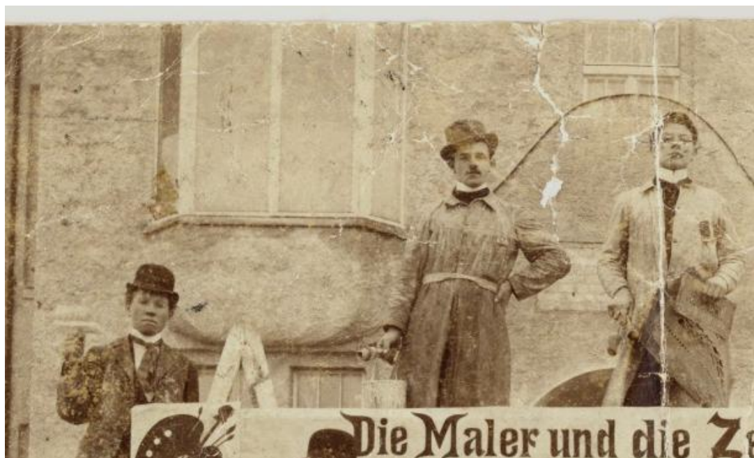
Fot. 2 Fragment elewacji frontowej w 1910 roku. W tle widoczny oryginalny tynk nakrapiany.
