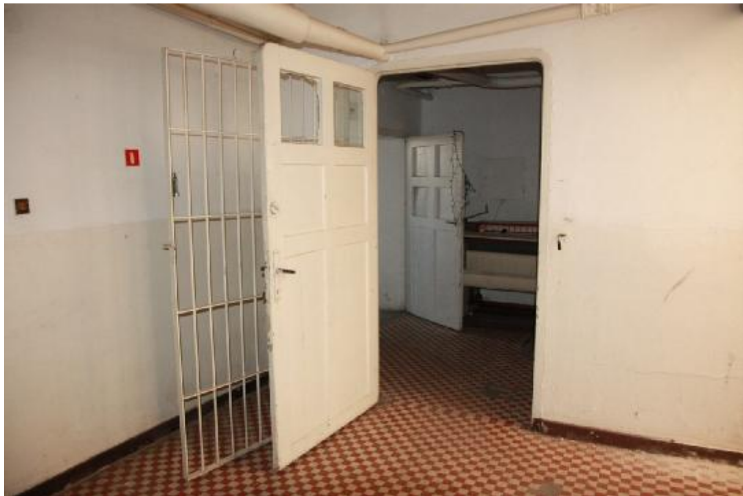
Fot. 69 Przejścia do pomieszczeń gospodarczych w piwnicy. Na podłodze oryginalna posadzka z kafli ceramicznych.
