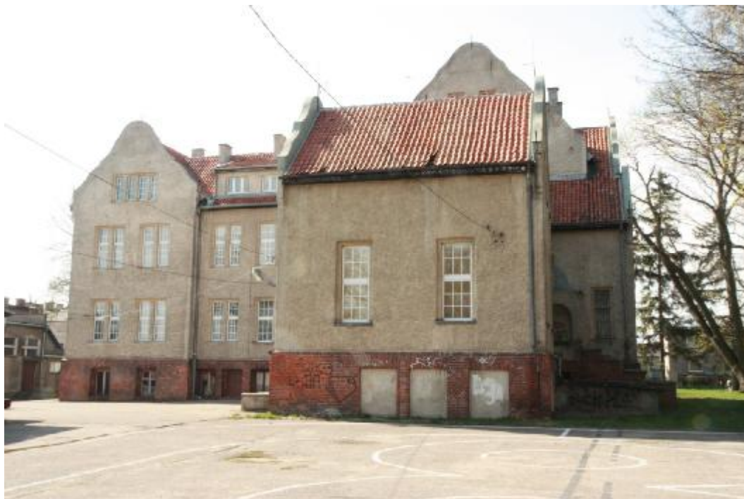
Fot. 7 Widok ogólny od strony południowo – wschodniej.
