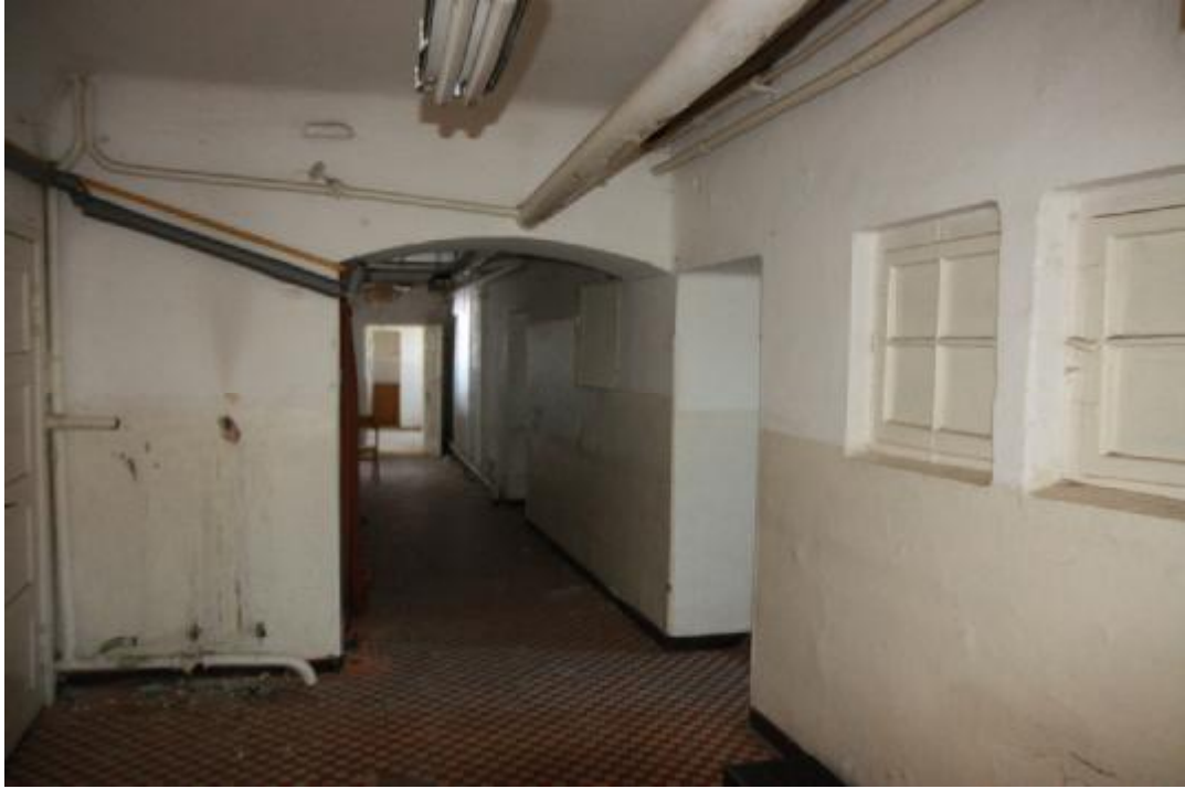
Fot. 68 Korytarz w piwnicy. Po prawej stronie oryginalne okienka w ścianie działowej.
