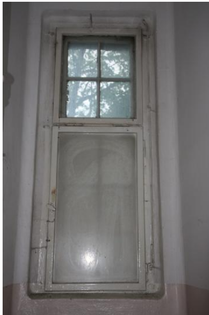
Fot. 47 Oryginalne okno w toalecie na parterze od strony Pn-Wsch.
