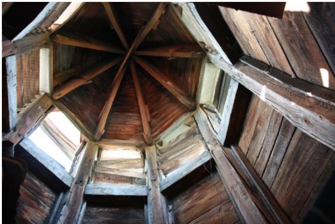
Fot. 75 Wnętrze wieżyczki nad główną bryłą budynku.
