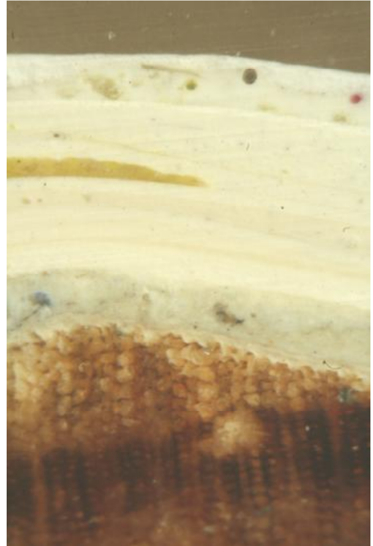
Fot. 108 Przekrój próbki 14. Na drewnie oznaczono 12 warstw farb. Pierwsze dwie warstwy są oryginalne. Drewno malowano najpierw na biało, a potem jasnozielono.
