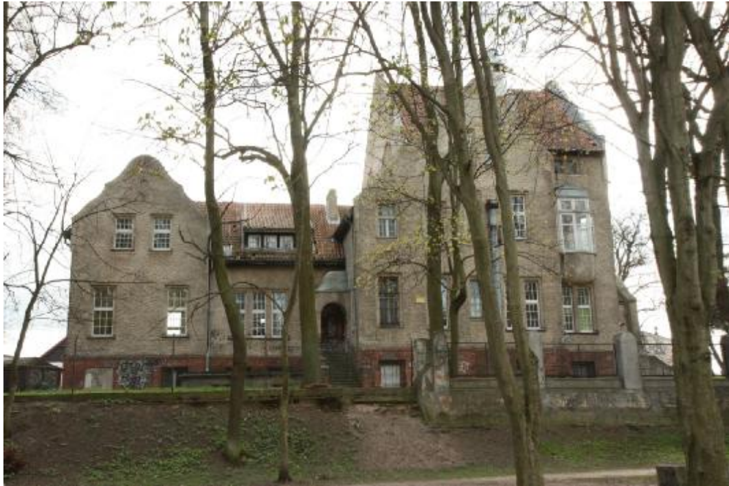
Fot. 17 Widok ogólny elewacji od strony północno – wschodniej (od strony parku).
