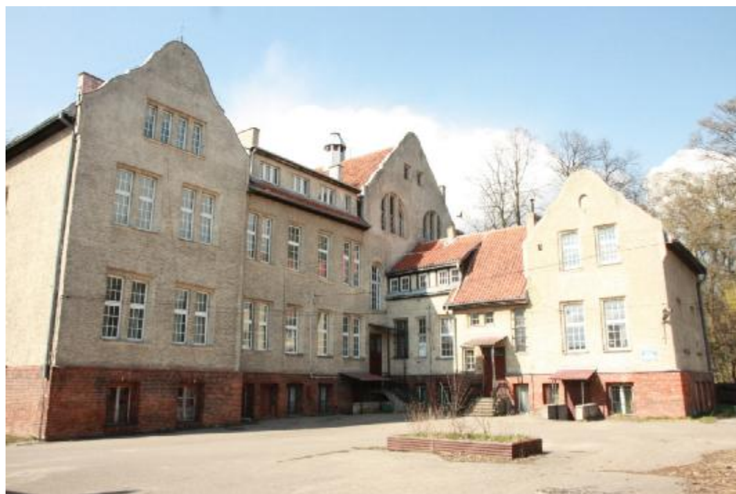
Fot. 8 Widok ogólny od strony południowej.
