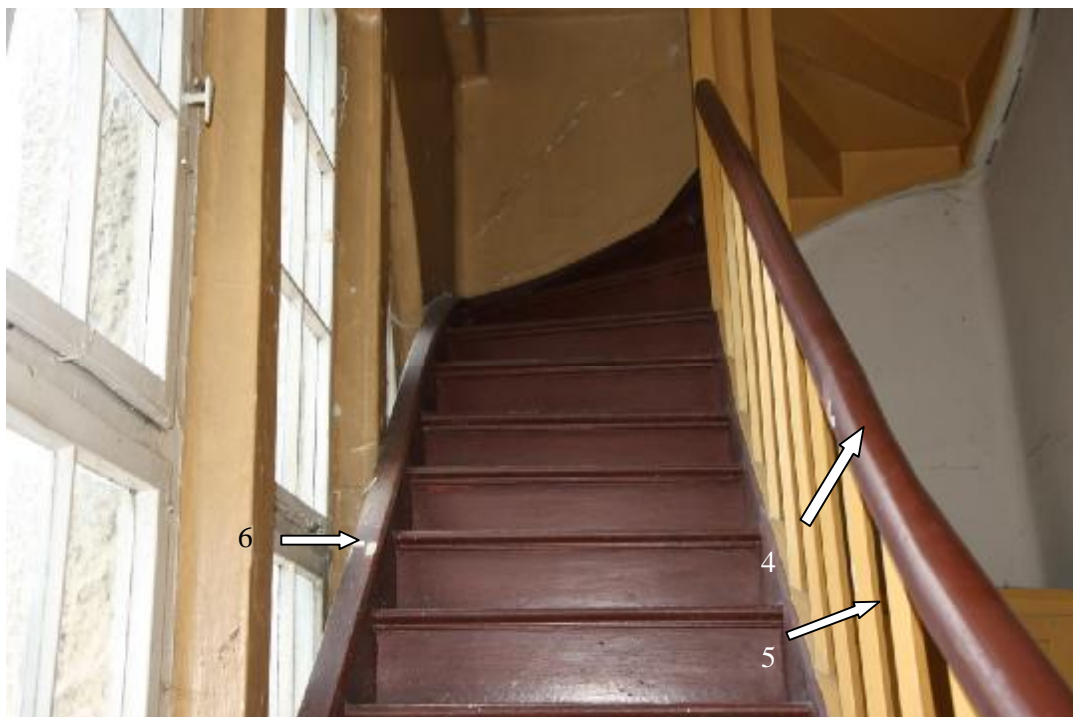
Fot. 85 Fragment schodów prowadzących na strych. Schody zachowane są w stanie doskonałym. Zaznaczono miejsce pobrania próbki 4, 5, 6.
