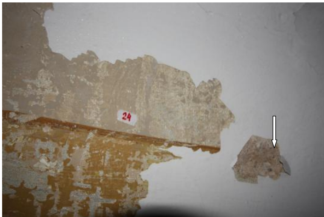
Fot. 137 Odkrywka na ścianie głównego hallu, tuż pod sufitem. Zauważyć można, że podział barwny ściany był urozmaicony poprzez wymalowanie poziomej, ciemnoczerwonej linii bardzo wysoko, około 50 cm pod sufitem. Ścianę poniżej linii wymalowano w kolorze oliwkowo-pomarańczowym, a powyżej biało-szarym..
