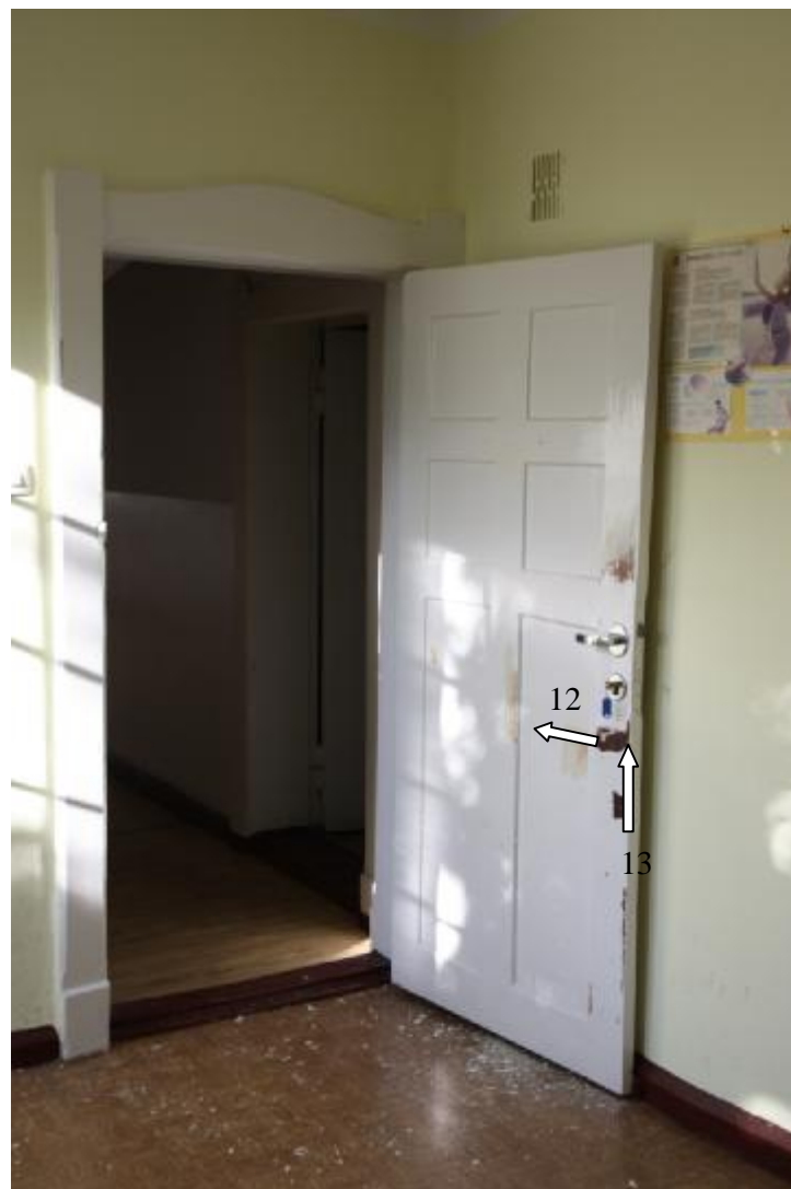
Fot. 102 Drzwi do sali w końcu korytarza, w głównym skrzydle, na II piętrze. Zaznaczono miejsca pobrania próbek 12 i 13. Próbkę 14 pobrano z drewnianego obramienia tych drzwi, z przeciwnej strony.
