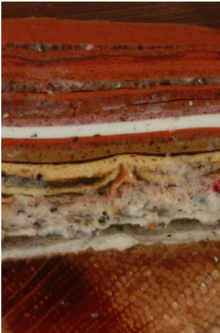
Fot. 129 Odkrywka na drzwiach frontowych. Pod warstwami wielu wtórnych przemalowań znajduje się wielobarwny mazerunek. Warstwę wierzchnią ma w kolorze oliwkowym. Zaznaczono miejsce pobrania próbki 21.
